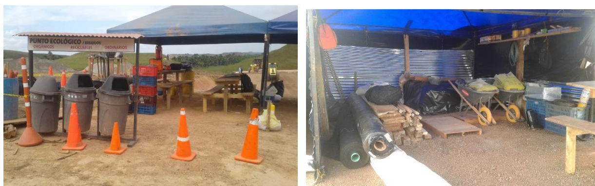
Figura 6-7. Instalacion de campamento.
