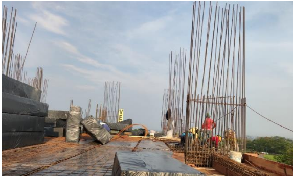
Ilustración 9 Montaje de acero casetón
