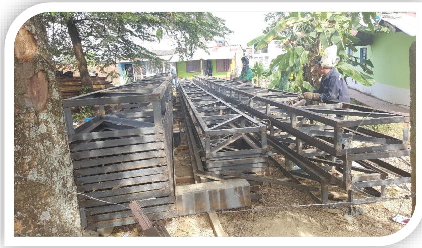
Ilustración 4, Obra Ingeniería y construcciones L&C S.A.S - Puerto Gaitán, Meta.
