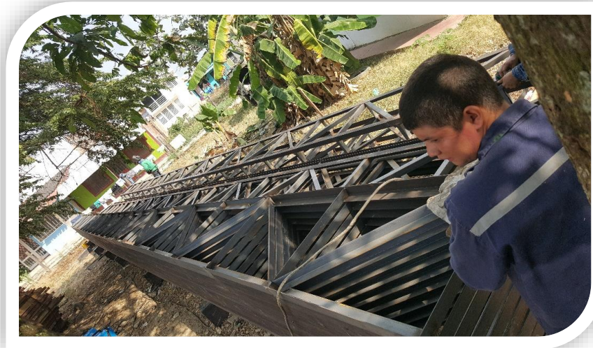
Ilustración 2, Obra Ingeniería y construcciones L&C S.A.S - Puerto Gaitán, Meta.
