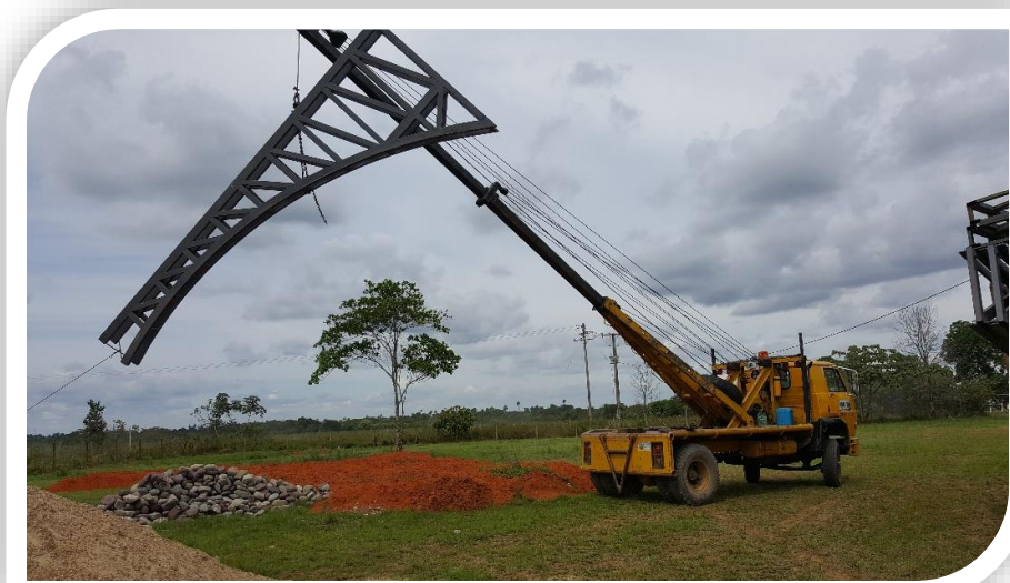
Ilustración 3, Obra Ingeniería y construcciones L&C S.A.S - Puerto Gaitán, Meta.
