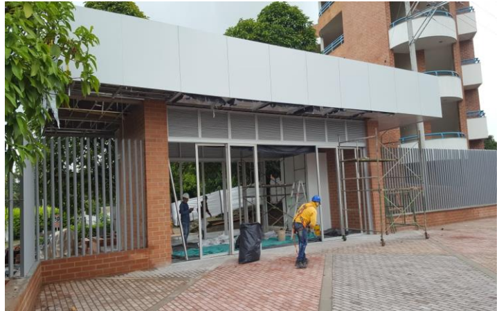
Ilustración 12 Seguimiento de obra
