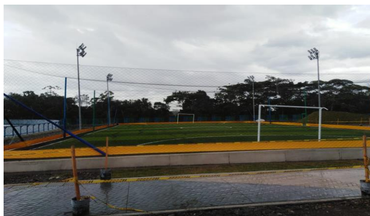
Figura 6: Visita técnica de obra contrato 2525 de 2019 (Cancha sintética fútbol 7).
