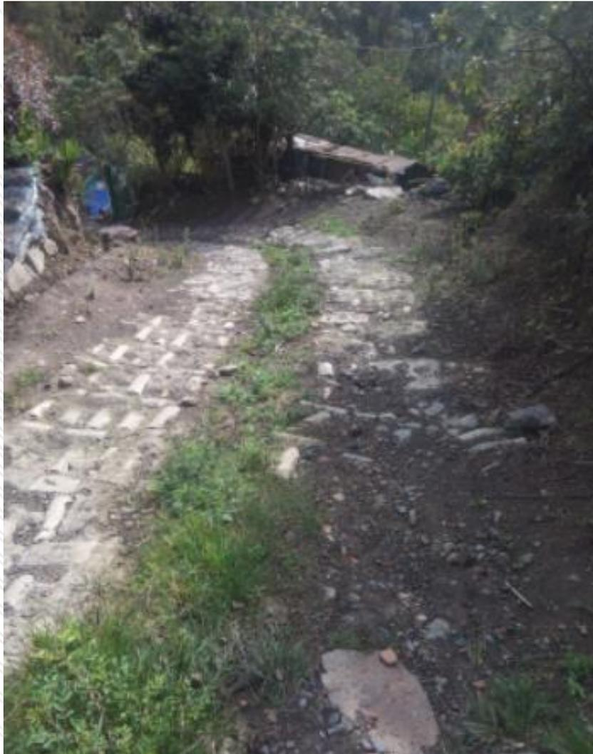
*Nota.* Vía de tercer nivel con placa huella antigua, que presenta deterioro por cambios en la estructura del suelo. Fuente: Propia
