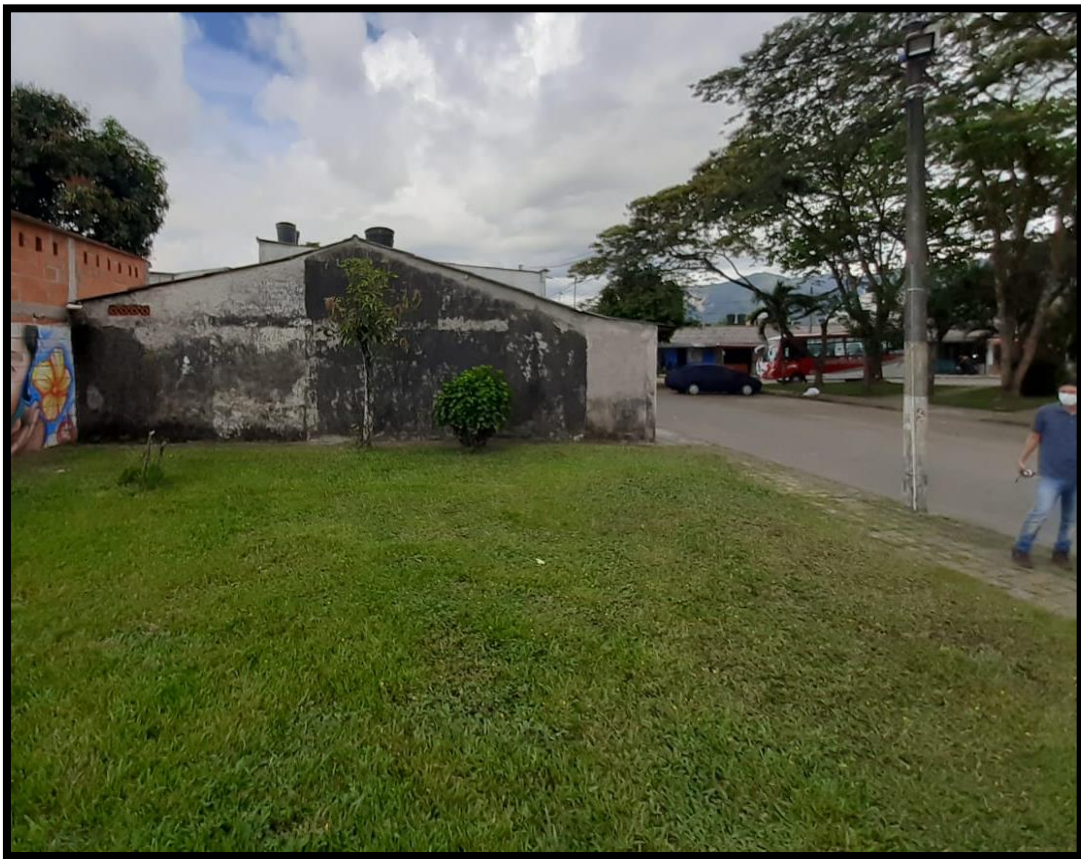
Ilustración 10 Toma de área salón comunal
