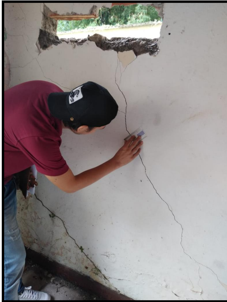
Ilustración 4 Fisuras fondo rotatorio
