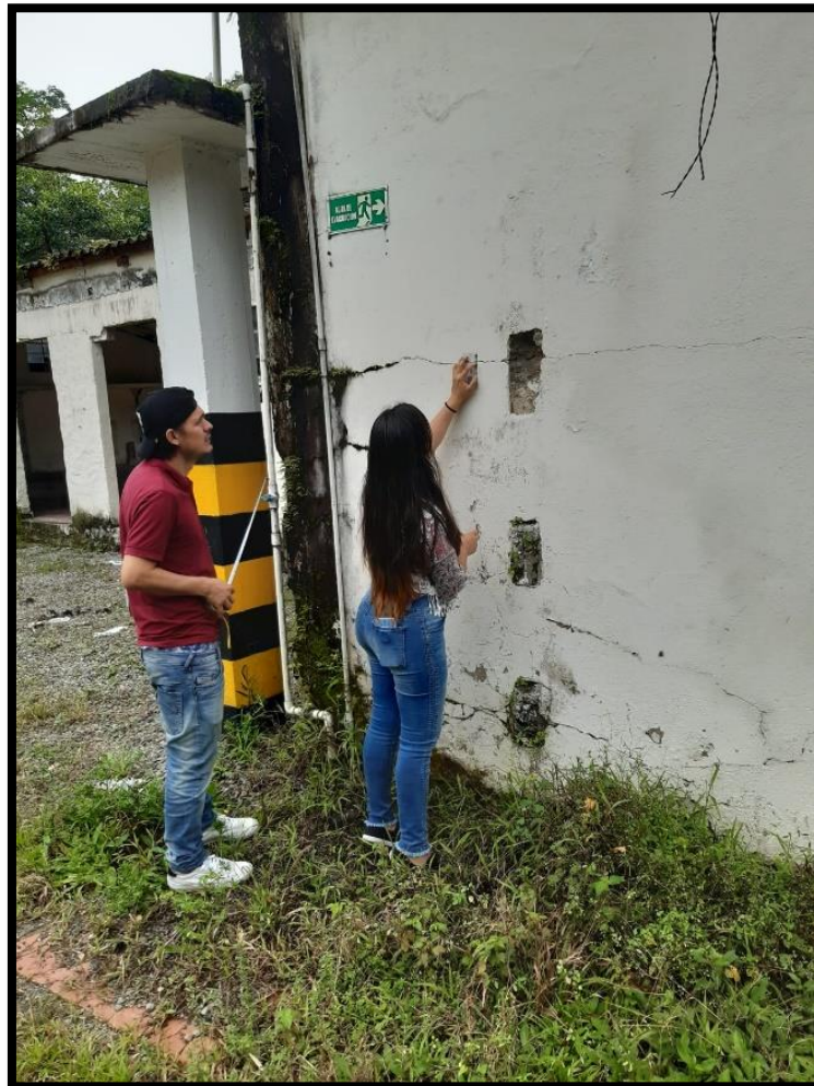
Ilustración 3 Toma de fisuras fondo rotatorio
