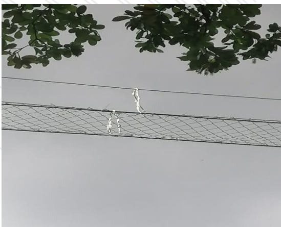
Fuente propia: vía nueva Villavicencio- Bogotá en la zona N°3
