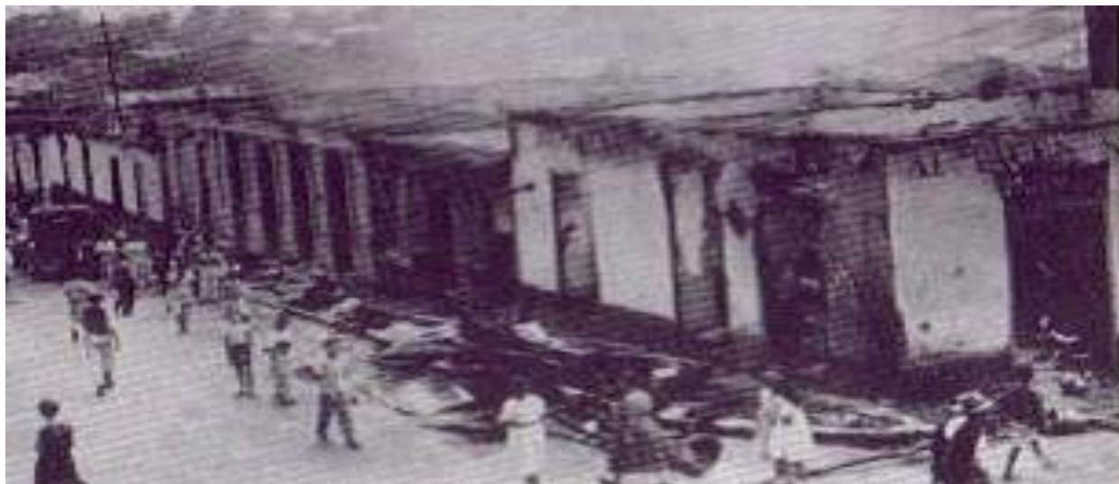
Figura 13. Segundo Incendio en 1951 siglo XX.
