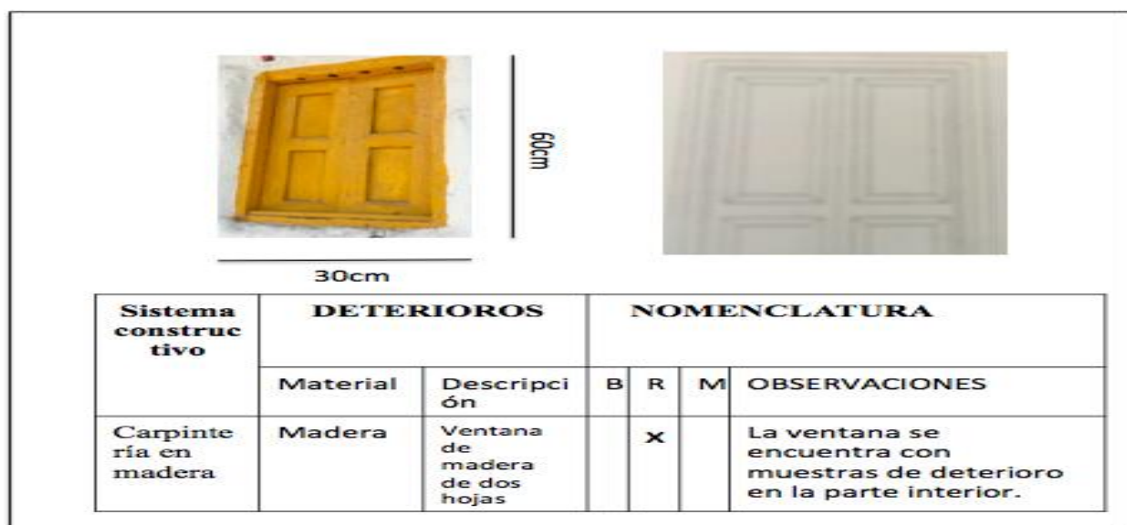
Figura 46. Estudio técnico constructivo 2.
