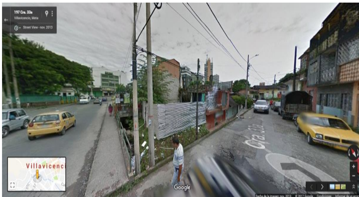
Figura 2. Vista antes de la demolición
