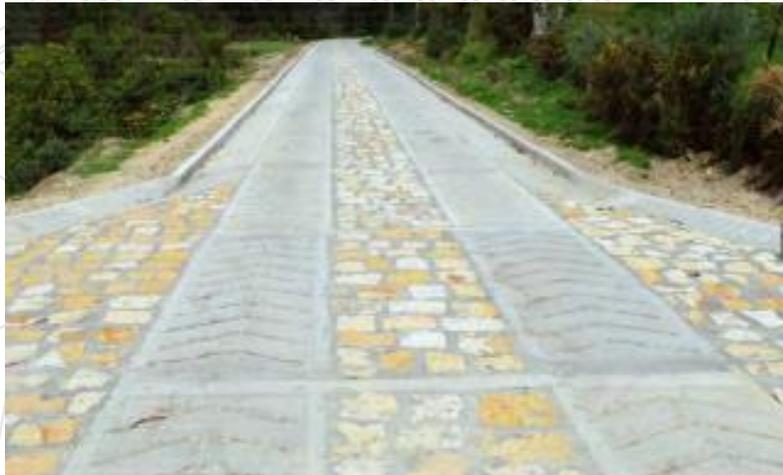
*Ilustración. 38. Representación del pavimento en placa-Huella*
