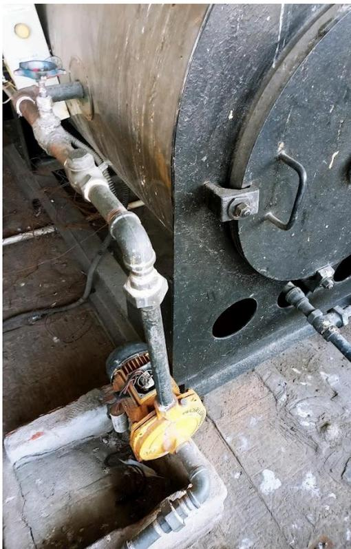
Fig. 24 Bomba de succión para llenado de la caldera
