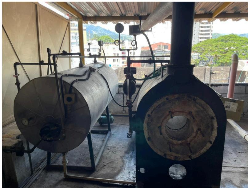
Fig. 5 Caldera pirotubular con sus sistemas
