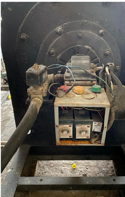
Fig. 22 Control de combustión
