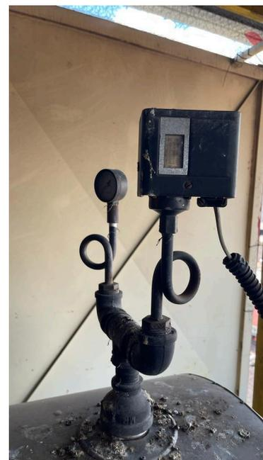
Fig. 19 Manómetro indicador de temperatura del condensador
