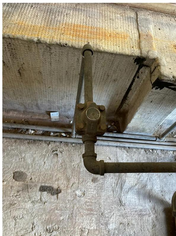
Fig. 27 Tubería de purga caldera
