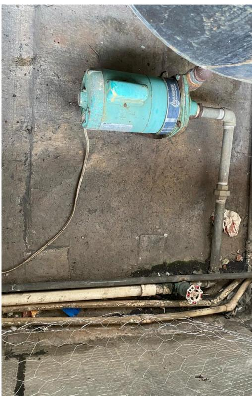
Fig. 26 Bomba de succión para llenado de la caldera
