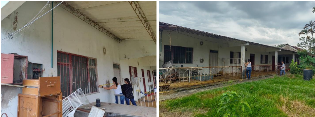
Figura 18 – Registro fotográfico de visita.
