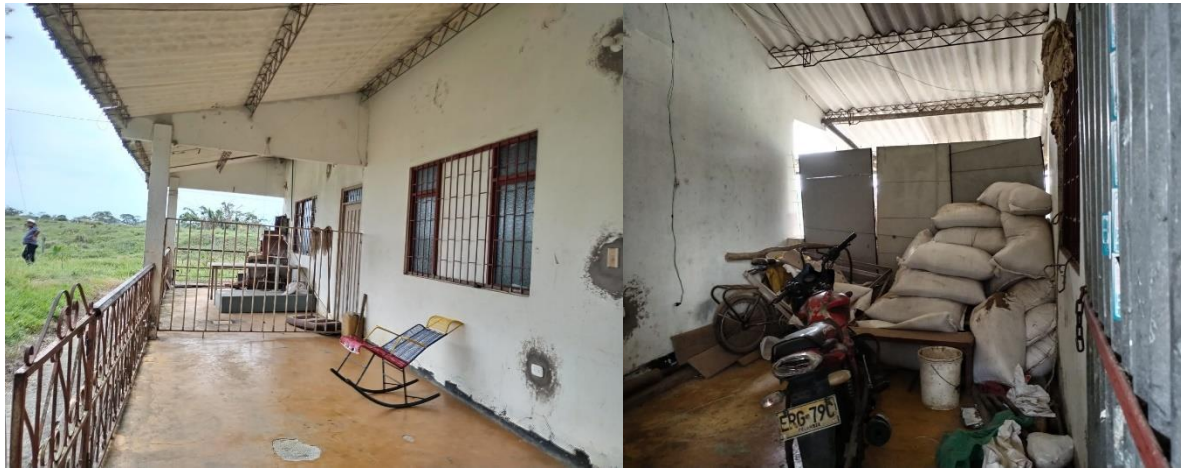
Figura 12 – Evidencia de visita a obra
