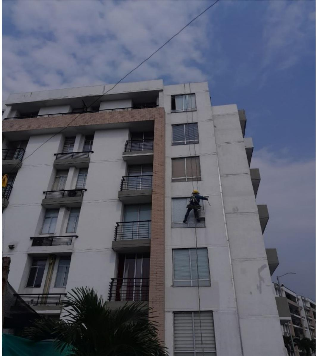
*Figura 4. Aplicación de pintura acrílica de alta resistencia KORAZA DOBLE VIDA 10*
