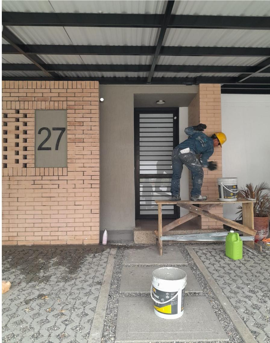
*Figura 5 Aplicación de Rinse Combi para garantizar la durabilidad del ladrillo.*
