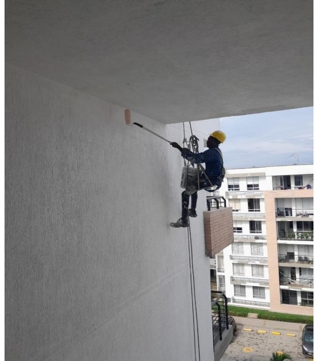
*Figura 25 Aplicación de Pintura Koraza en exterior de torre*
