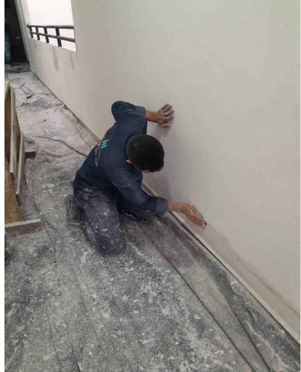
*Figura 24 Aplicación de Viniltex en puntos fijos*
