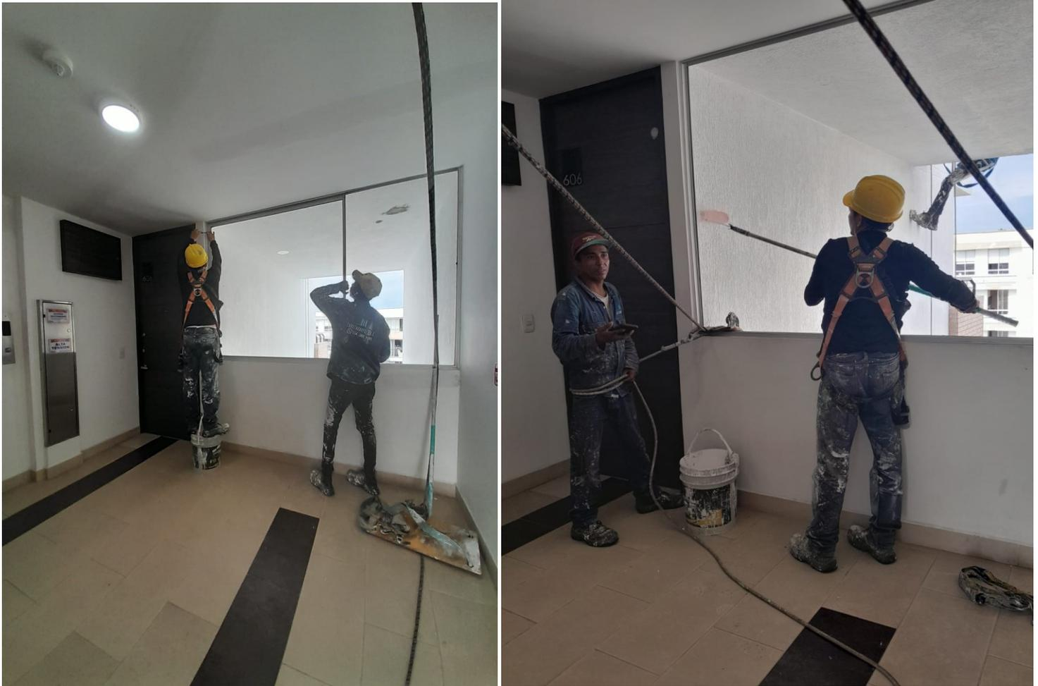
*Figura 14 Desmonte de ventanal y aplicación de pintura KORAZA*
