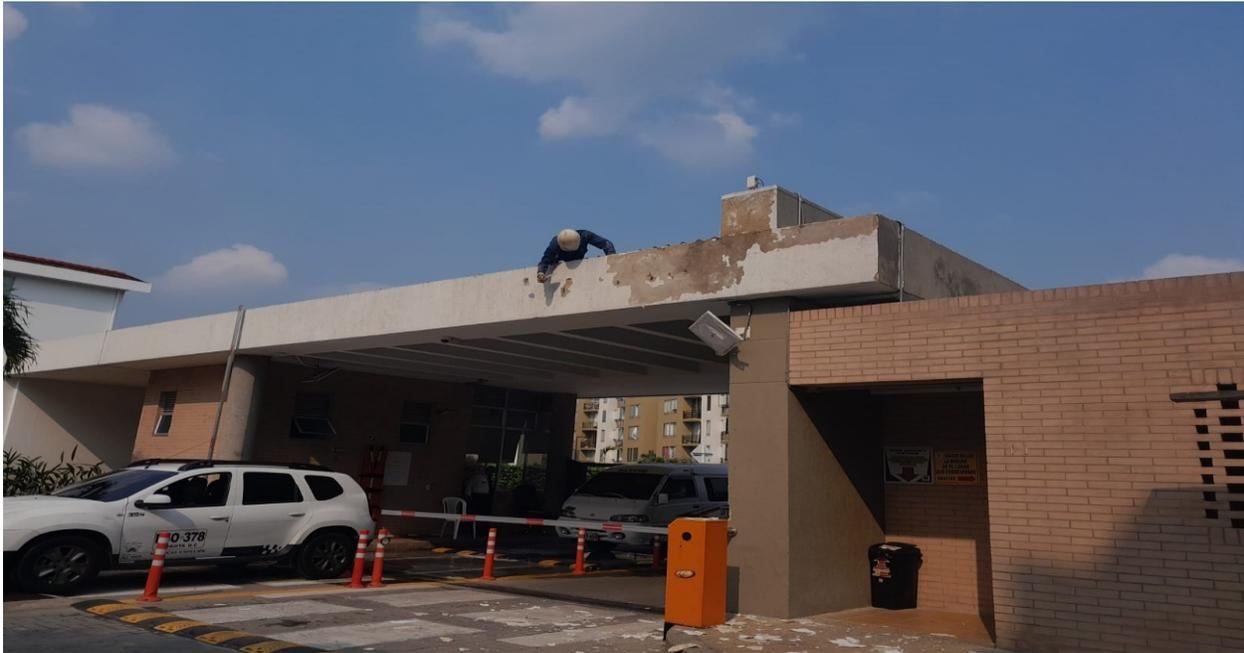
*Figura 11 Raspado de antepecho lineal*
