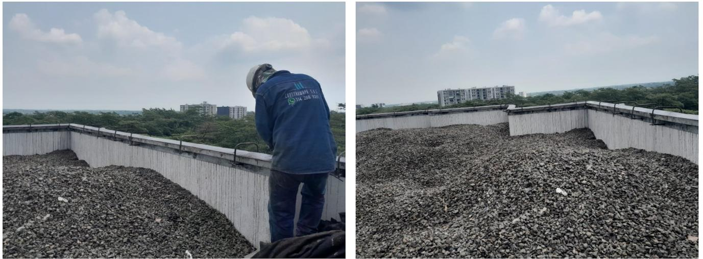
*Figura 10 Montaje de formaleta para alfajías torre 8*
