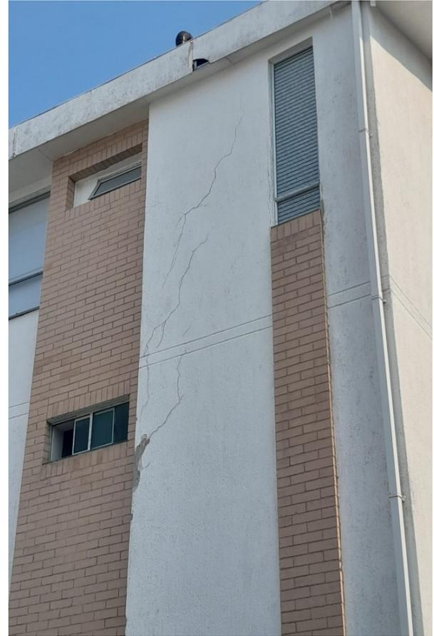
**Figura 3. reconocimiento de falla estructural en fachada lateral izquierda de vivienda**
