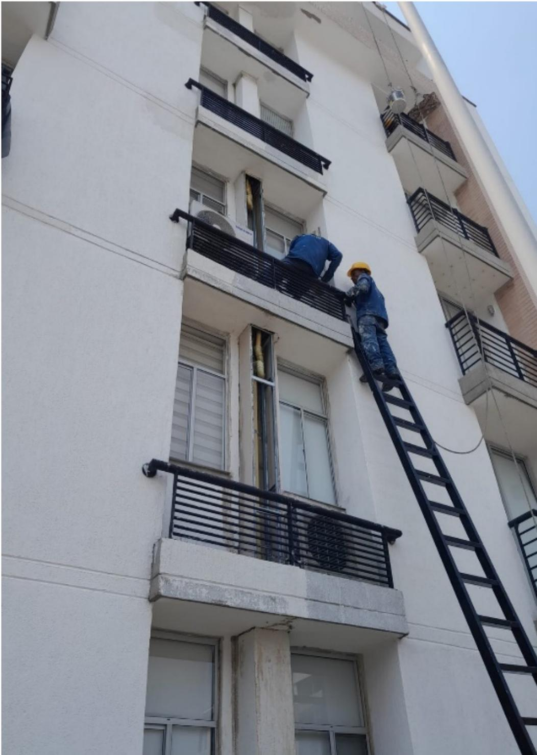
*Figura 29 Mantenimiento en balcones e identificación de daños estructurales en fachada*
