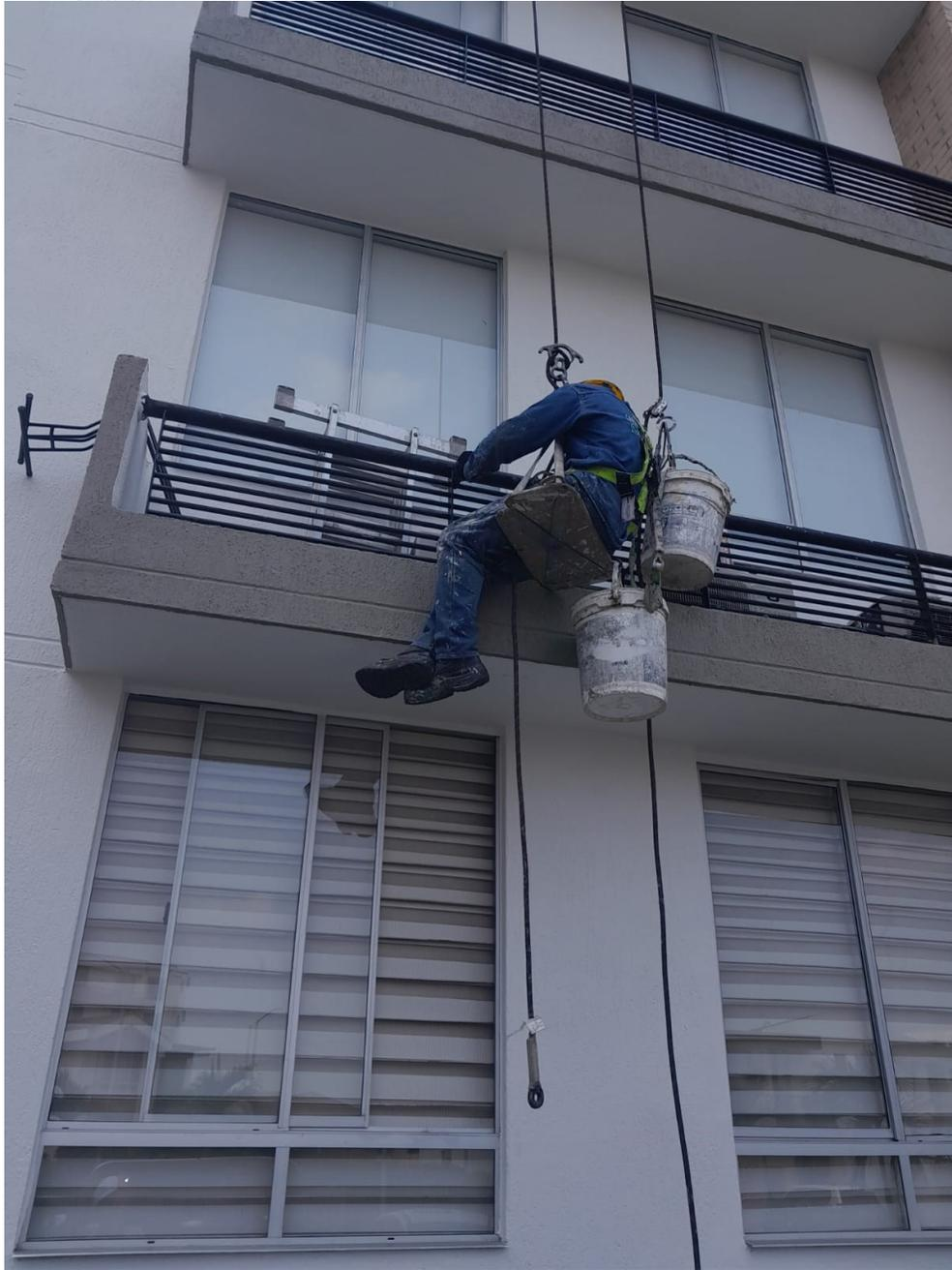
*Figura 17 Aplicación de pintura en barandas de balcones Pintulux 3 en 1*
