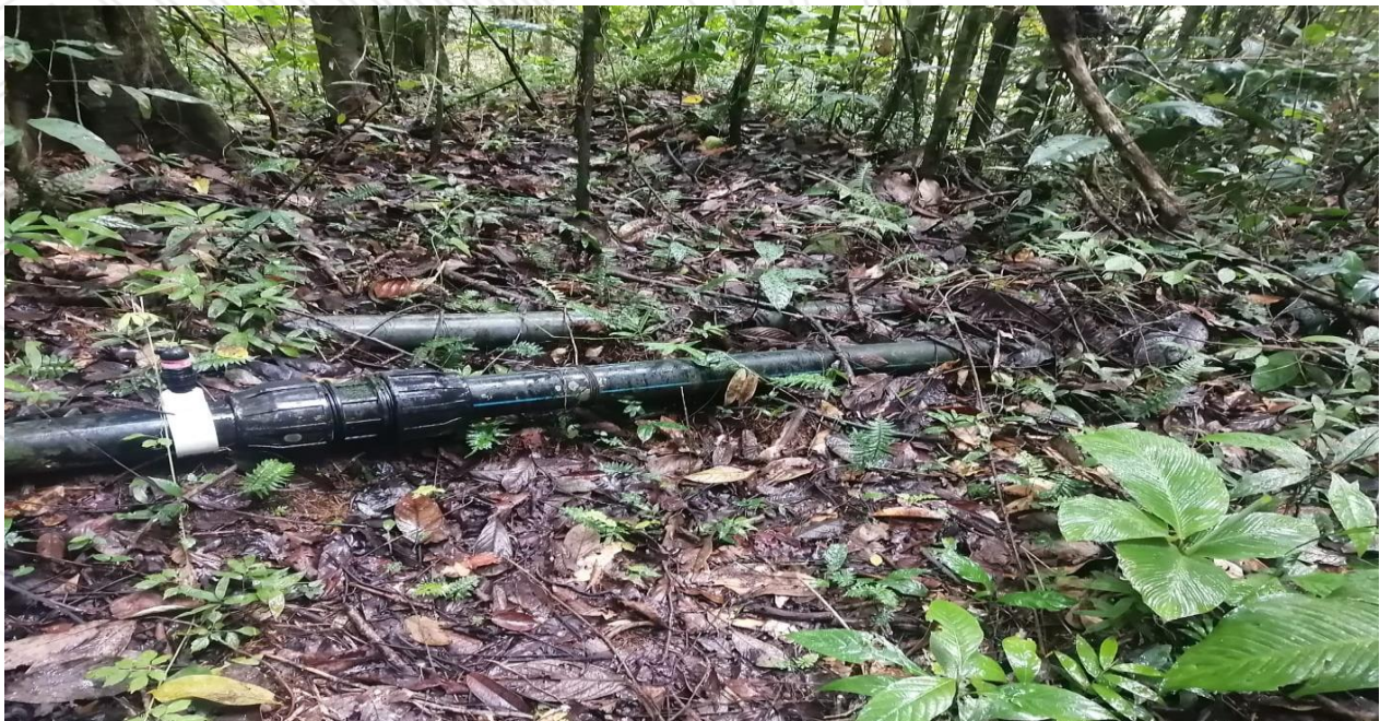
Figura 18. Tubería de adopción sobre cota rasante.
