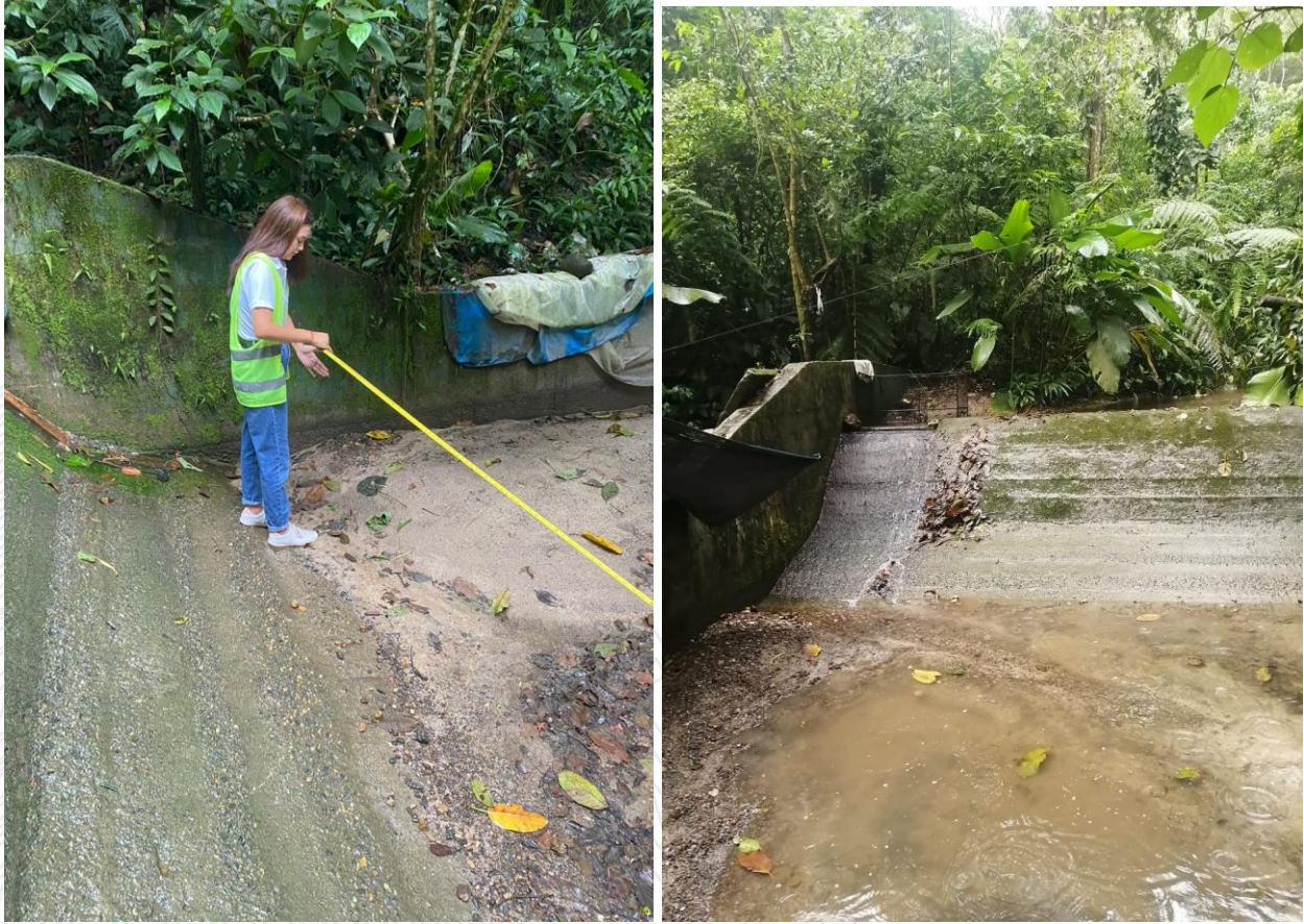
Figura 14. Toma de medidas del punto de captación.
