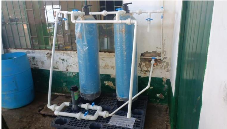
Evidencia de la inspecciones y mantenimiento de filtros polyglass de la empresa, en las imgenes de los filtros se muestra la turbidez del agua en el proceso de retrolavado de los filtros.
