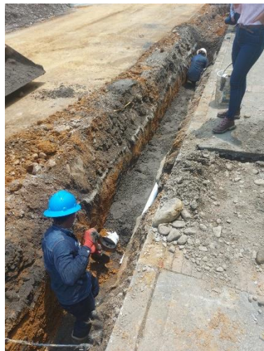
Figura 6 Registro fotografico instalacion de tuberia proyecto calle 15
