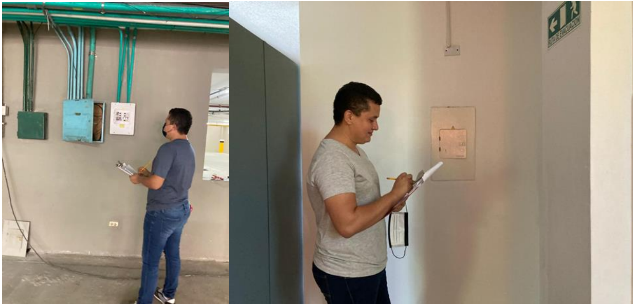
Ilustración 14 Inspección de señalización de riesgo eléctrico y de evacuación
