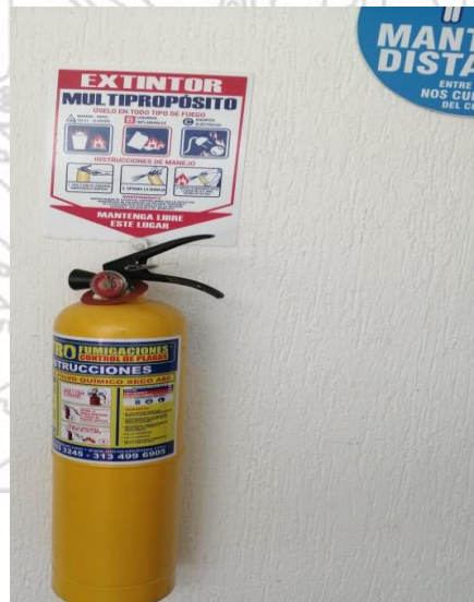
Figura 20. inspección de extintor segundo piso
