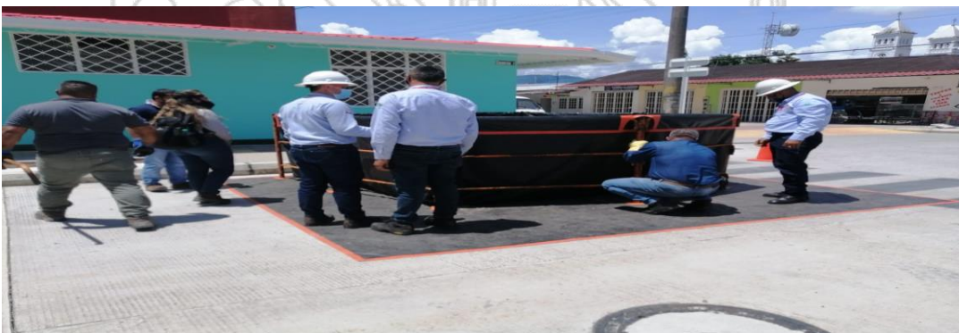
Figura 12, Actuando de esta manera creando una poceta o piscina, el líquido no sigue transitando y vamos a reducir el impacto.
