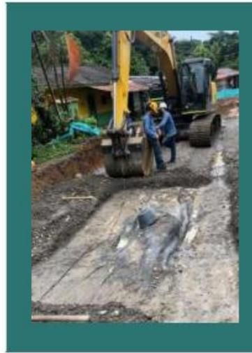
Para mejorar una subrasante de suelo blando es recomendable adicionar algún material granular, lo que compensará el control de fallas que genera el geotextil tejido ya que se mitigará la expansión del suelo que la compone y aumentará la capacidad portante del suelo.
