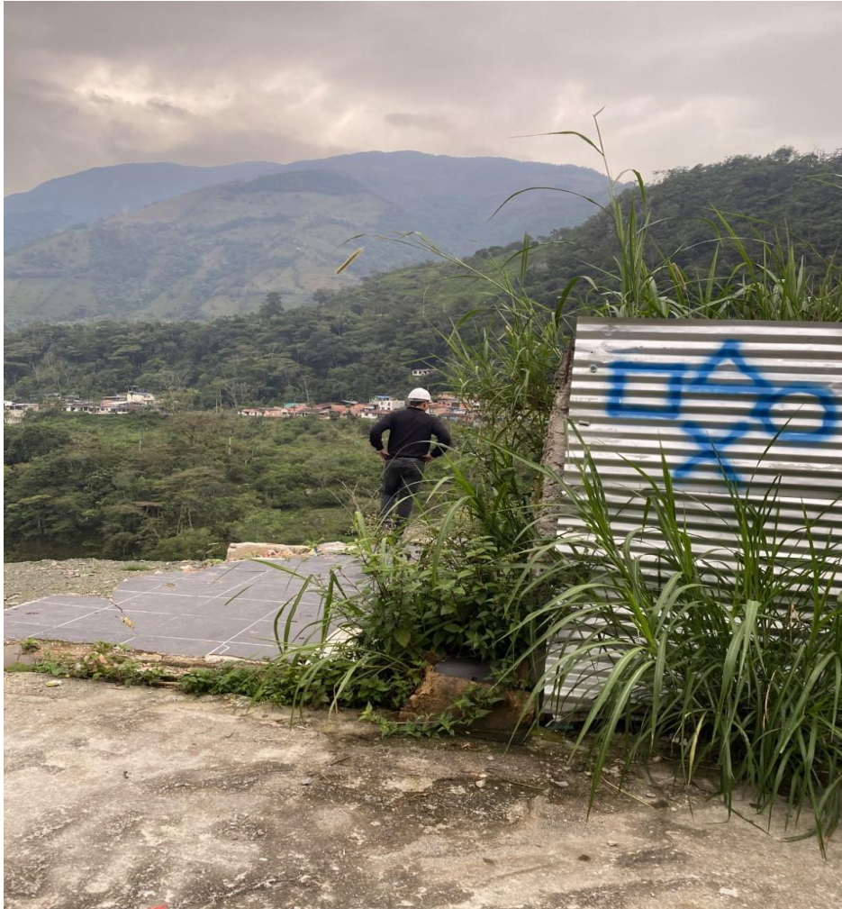
Ilustración 6. Zona de construcción del muro (vista superior) Fuente: Propia
