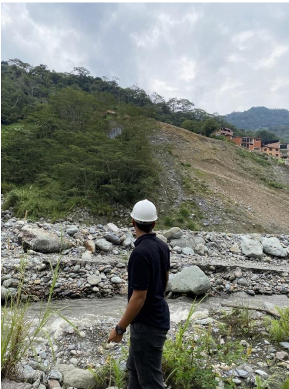
Ilustración 4. Zona de construcción del muro de contención (vista inferior) Fuente: Propia
