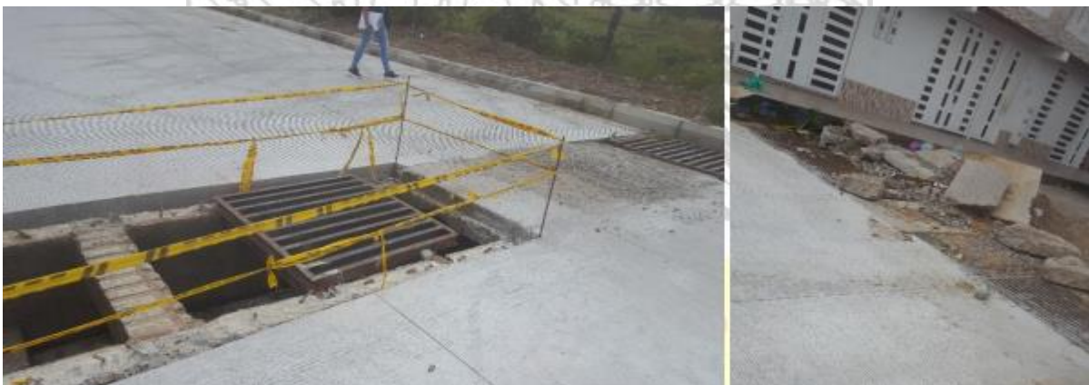
Figura 8. Reparación de rejillas. Fuente: Propia.
