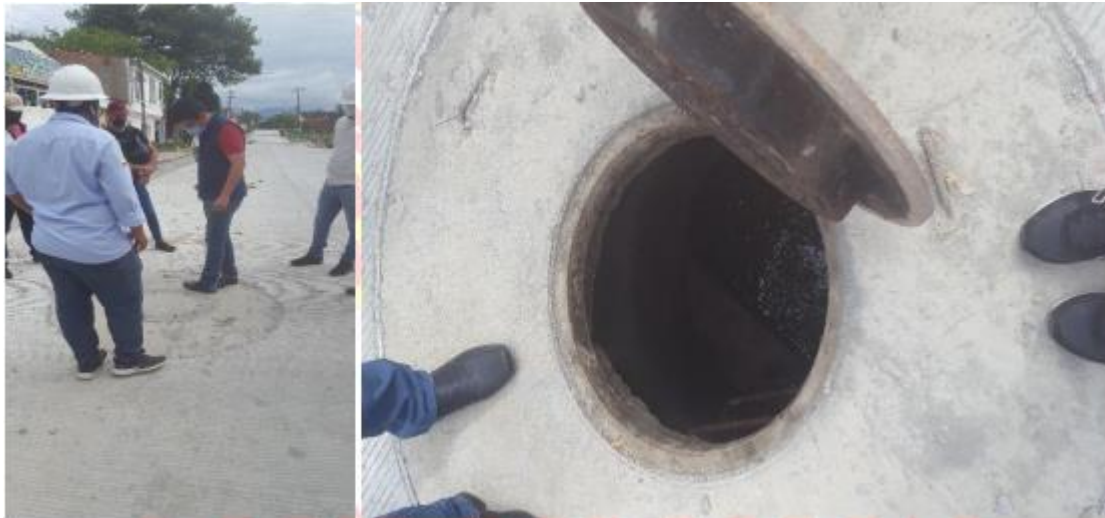
Figura 5. Pozo de Inspección Fuente: Propia.
