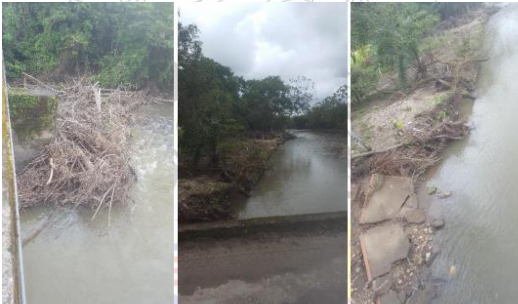
Figura 9. Arrastre de material en el río.
