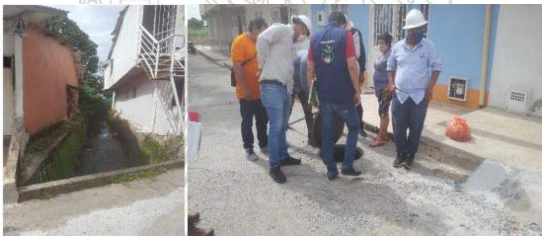
Figura 6. Tubo de canal de aguas lluvias. Fuente: Propia.
