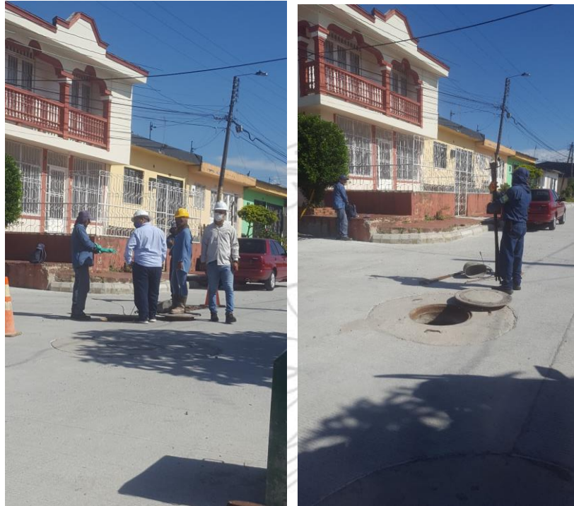
Figura 21. Limpieza de alcantarillado. Fuente: Propia
