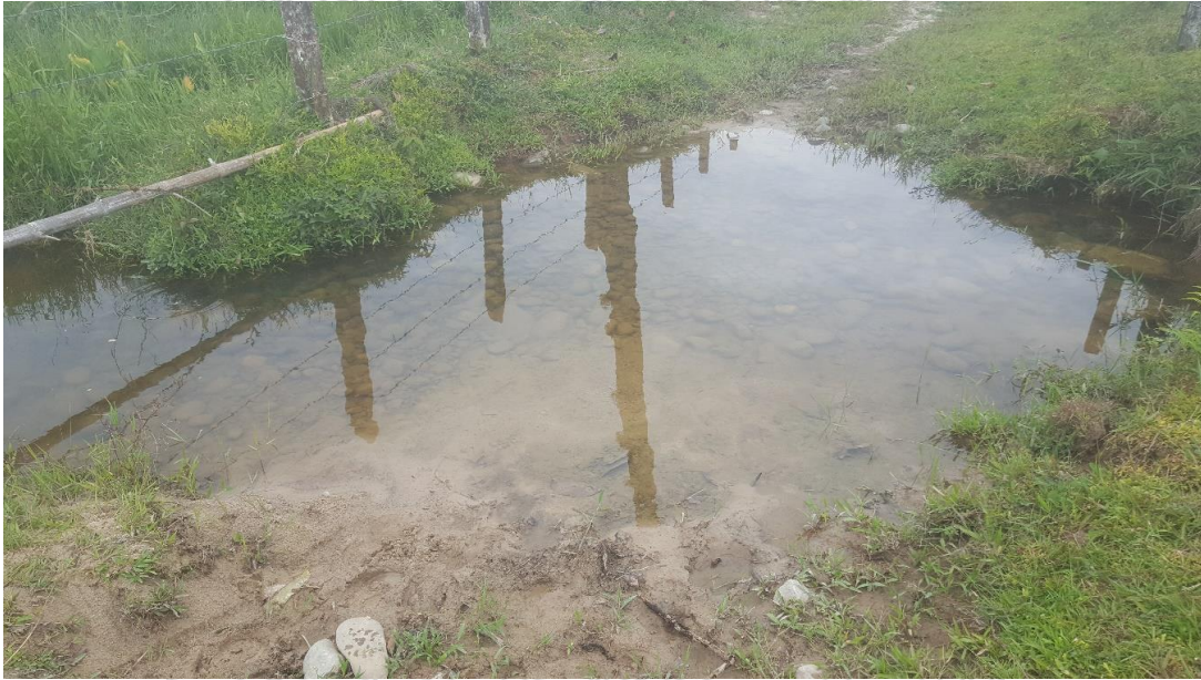
Figura 17. Aposamiento de aguas en el camellón.
