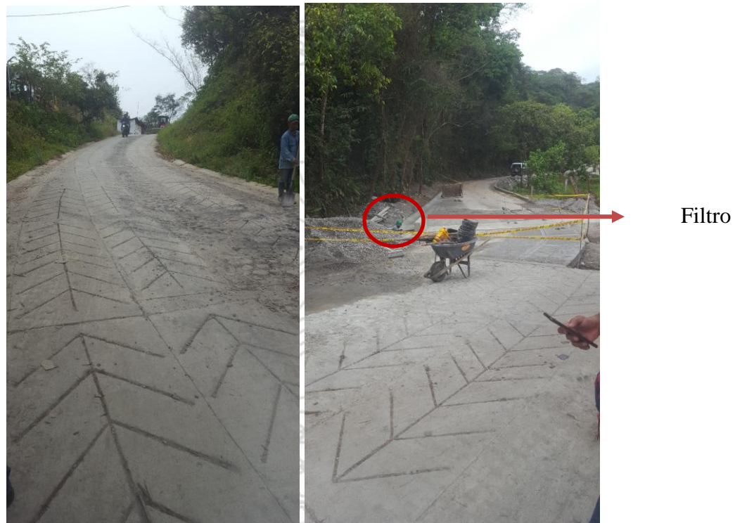
Figura 18. Avance de las placas huellas tipo 3. Fuente: Propia
