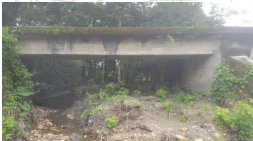
Figura 15. Ondulación de la estructura por el exceso de peso. Fuente: Propia.
