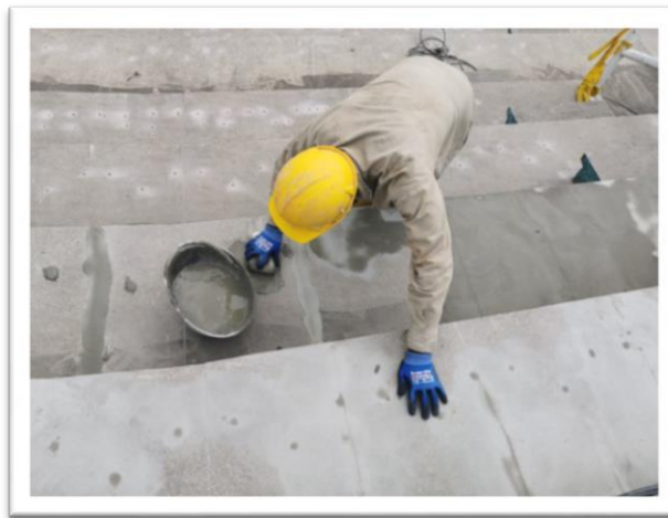
Lavado de graderías para la posterior rehabilitación de la superficie e impermeabilización.
