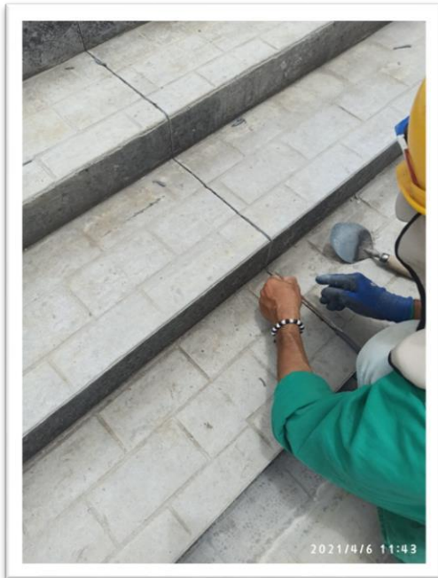
Instalación de sello en las dilataciones realizadas al concreto para prevenir fisuras.
