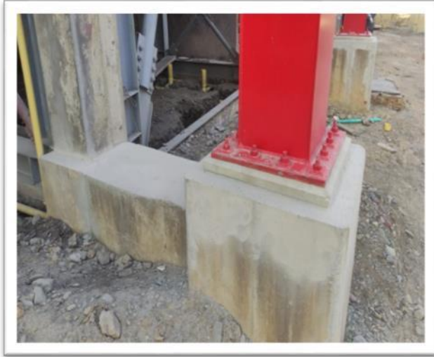
Pedestales de soporte de estructura metálica del estadio para soporte de fachada y cubierta.
