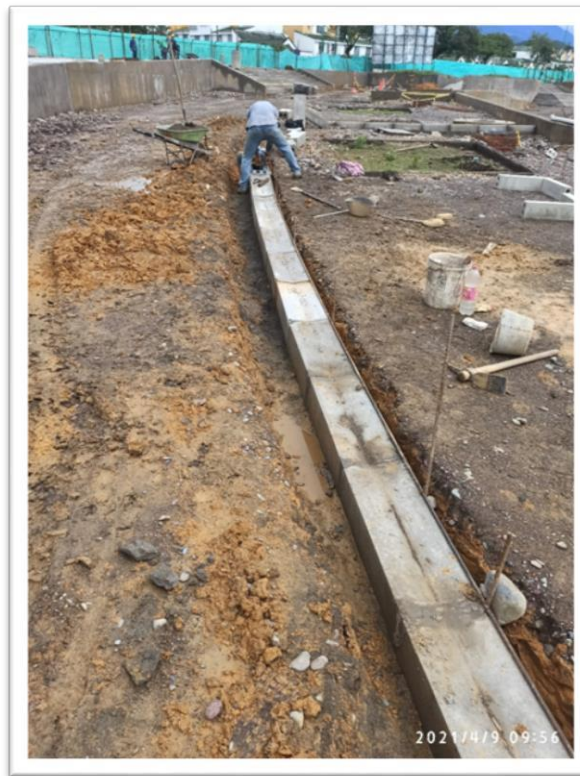
Instalación de cuneta prefabricada para la canalización de y conducción de aguas lluvias
