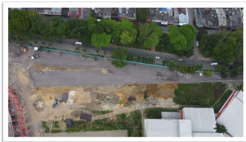
Reporte de avance en parqueadero norte.
