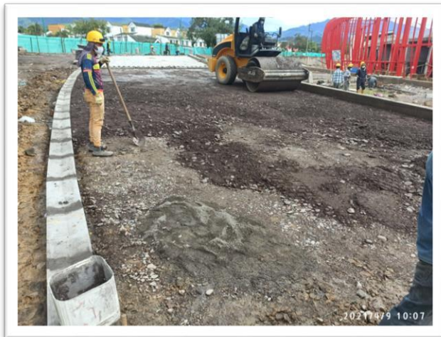
Compactación y nivelación de terreno para toma de densidades y la posterior instalación de loseta deck.
