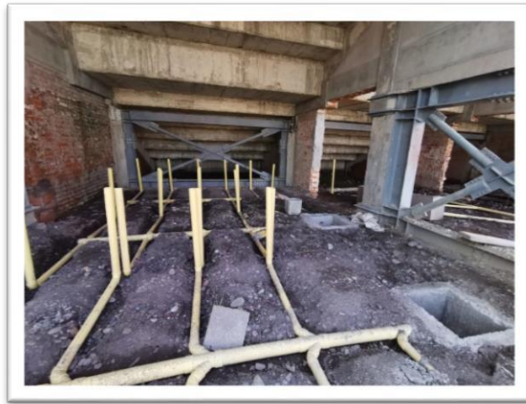
Verificación de la instalación de los desagües sanitarios de los baños del estadio.
