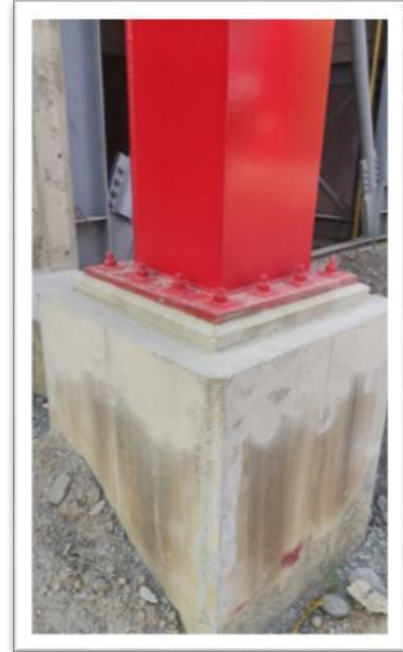
Pedestales de soporte de estructura metálica del estadio para soporte de fachada y cubierta.
