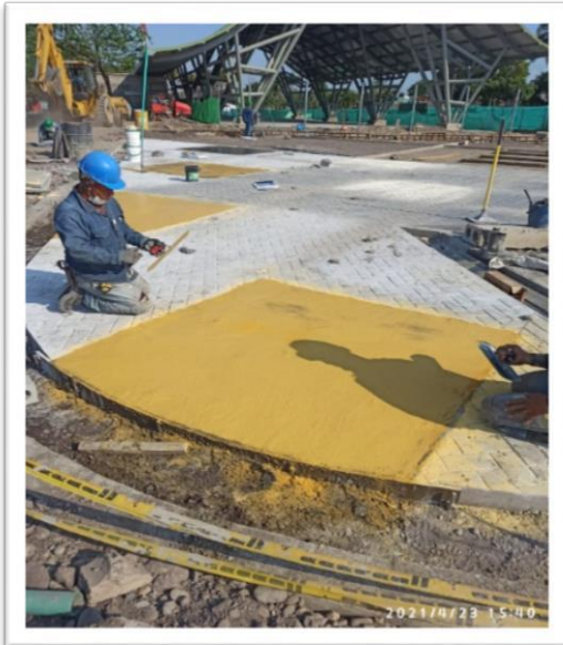
Construcción de concreto estampado para espacio público.
