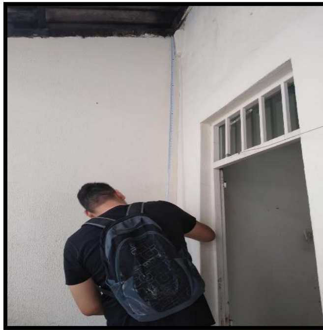
Ilustración 6: Levantamiento de grietas fondo rotatorio
