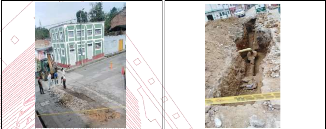
Ilustración 14. Excavación manual y con maquinaria pesada pajarita.
