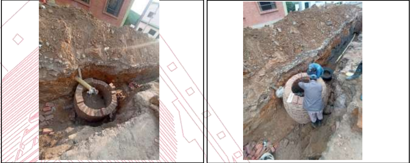
Ilustración 18. Construcción de pozo de inspección.
