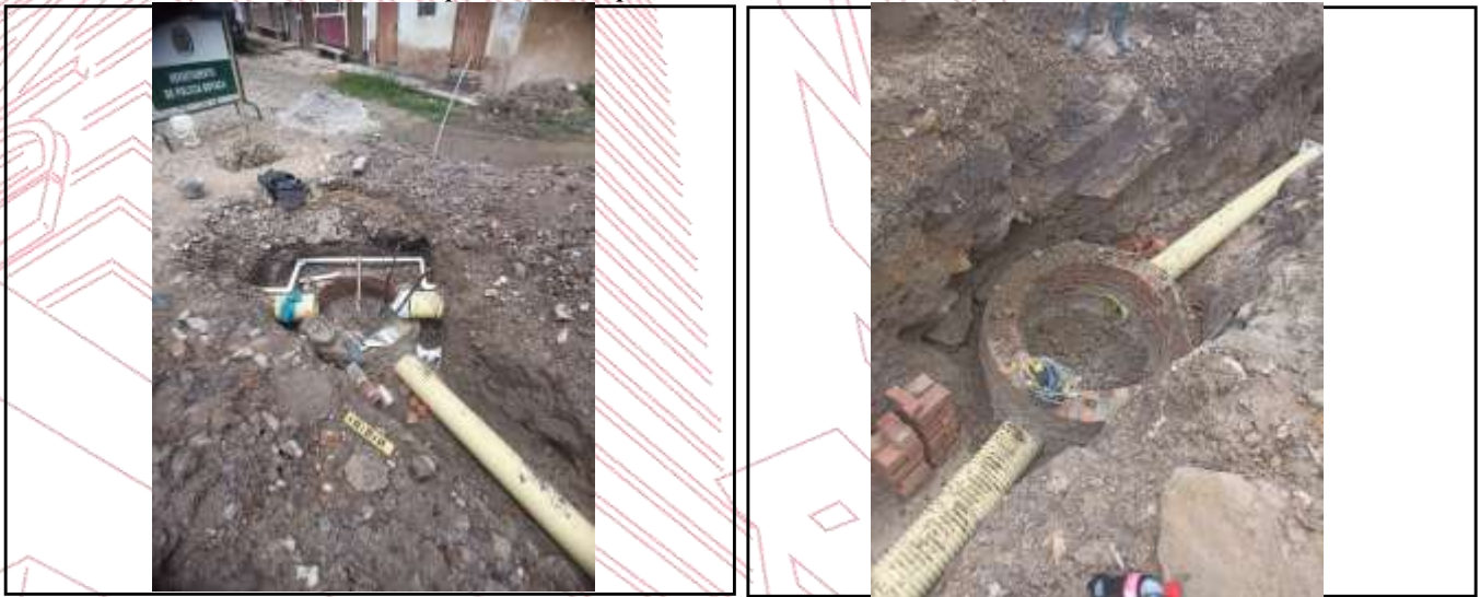
Ilustración 23. Elaboración de pozos de inspección.
