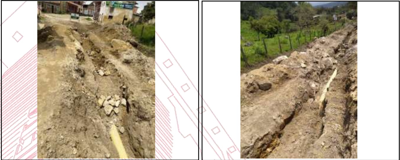
Ilustración 26. Cubrimiento del sistema de alcantarillado.
