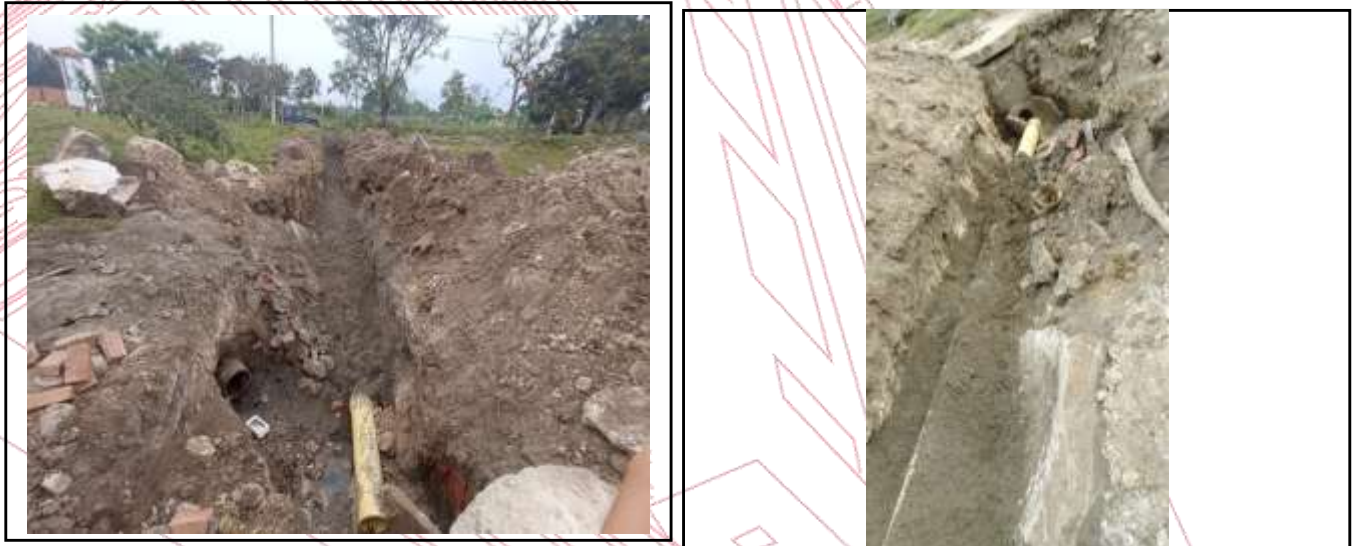
Ilustración 13. Cubrimiento de la tubería.
