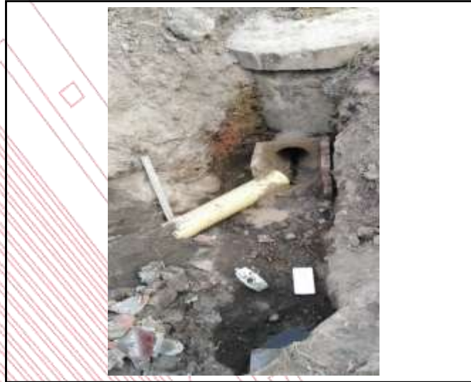
Ilustración 12. Elaboración de caja para la conexión de dos tubos.
