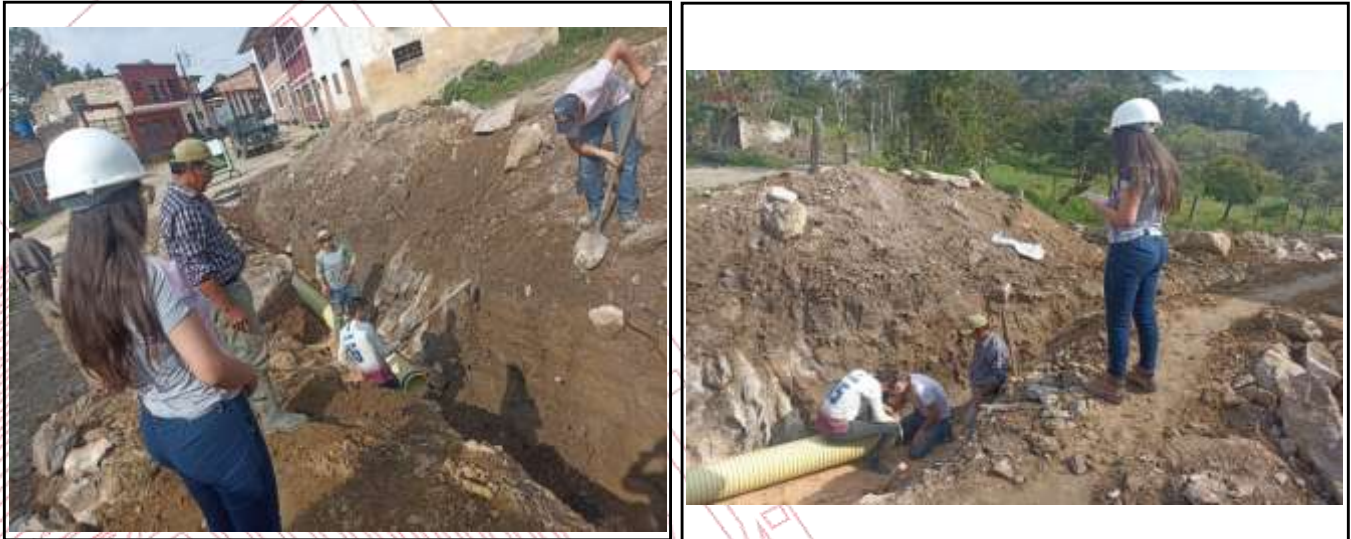
Ilustración 22. Instalación de tubería.
