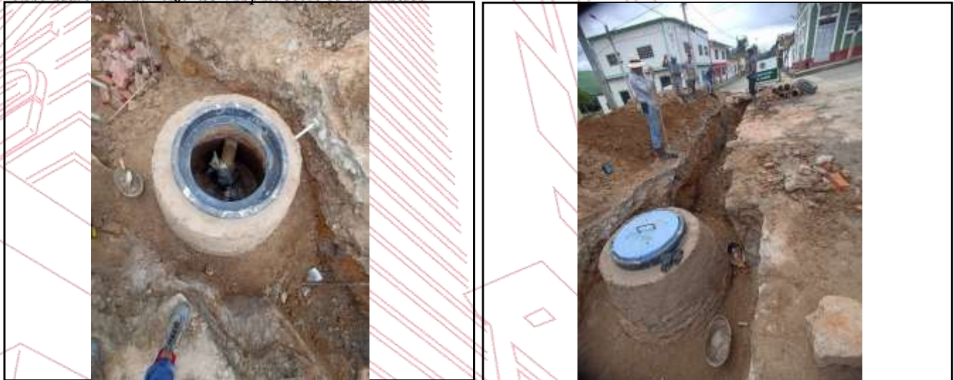
Ilustración 19. Pozo de inspección terminado.
