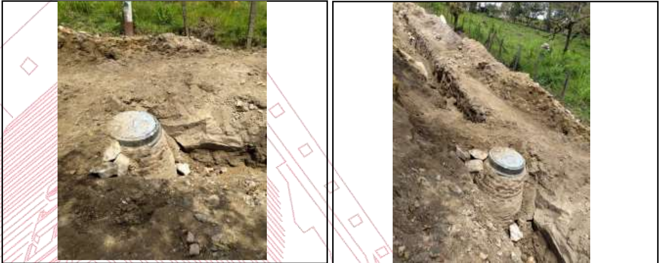
Ilustración 24. Pozos de inspección terminados.
