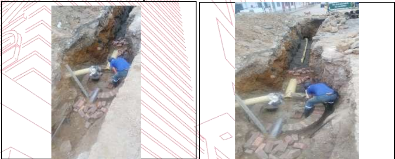
Ilustración 17. Construcción base de pozo
