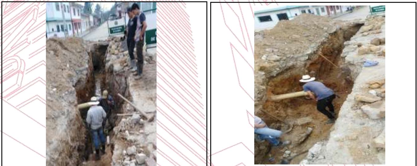
Ilustración 15. Toma de nivel.
