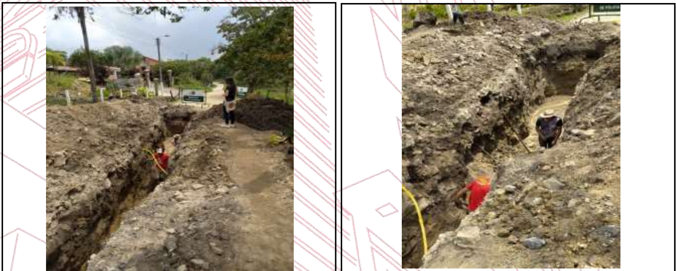
Ilustración 25. Toma de nivel.
