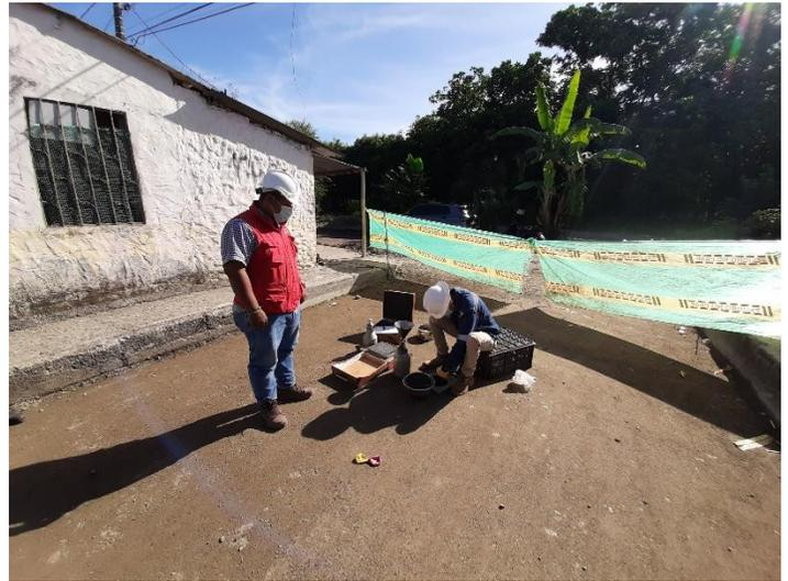
**Descripción:** Inspección a los diseños de mezclas y Densidades de rellenos para reposiciones de pavimento.
