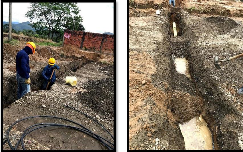
*Ilustración 14 EXCAVACION MANUAL DE TUBERIA*
