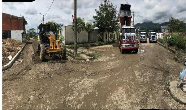
*Ilustración 20 SOBRE ACARREO DE MATERIAL, FACTOR DE EXPANSION 20%*
