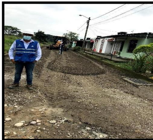
Ilustración 13 SOBRE-ACARREO DE MATERIAL, FACTOR DE EXPANSIÓN 20%.
