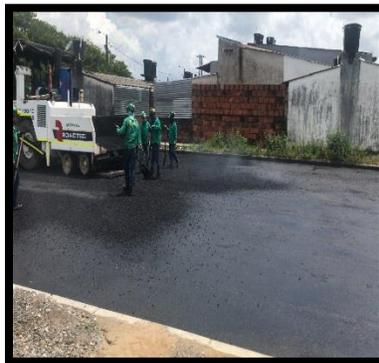
*Ilustración 9 RIEGO DE IMPRIMACION CON EMULSION ASFALTICA*
