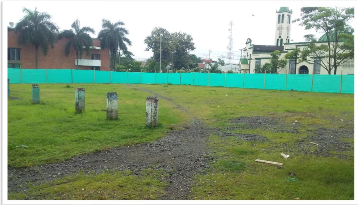
Imagen 17: terreno de obra antes de iniciar labores. Fuente: propia.
