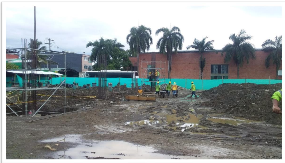
Imagen 18: excavaciones, implantación de acero de cimentación y columnas. Fuente: propia.
