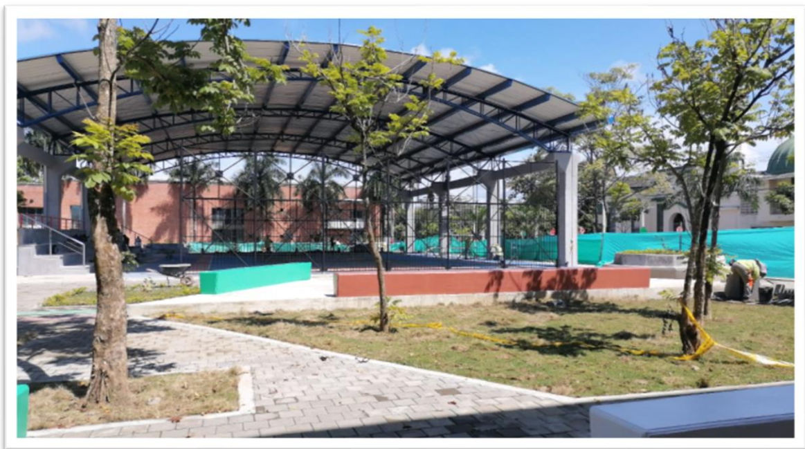
Imagen 20: proyecto terminado. Fuente: propia.
