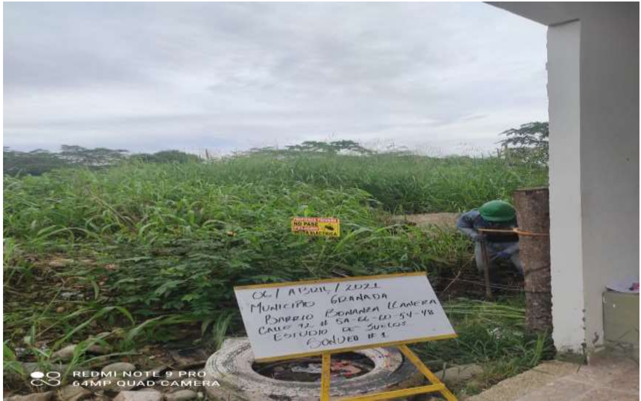
Registro fotográfico 6. Sondeo número 1 obtención de muestras lote 16 barrios Bonanza-Granada.
