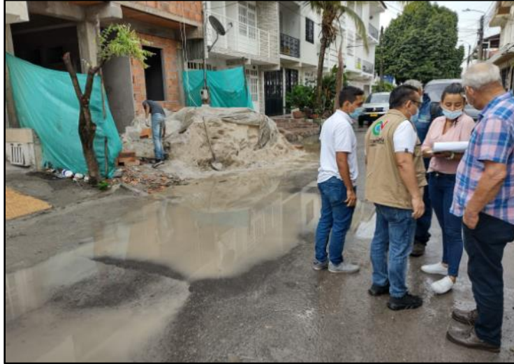
Ilustración 12: Visita técnica, contrato de obra No 115-2020.
