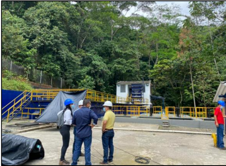
Ilustración 10: Visita técnica, contrato de obra No 117-2020
