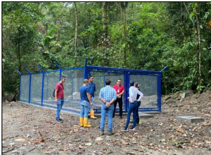
Ilustración 15: Visita técnica, contrato de obra 228 – 2019.
