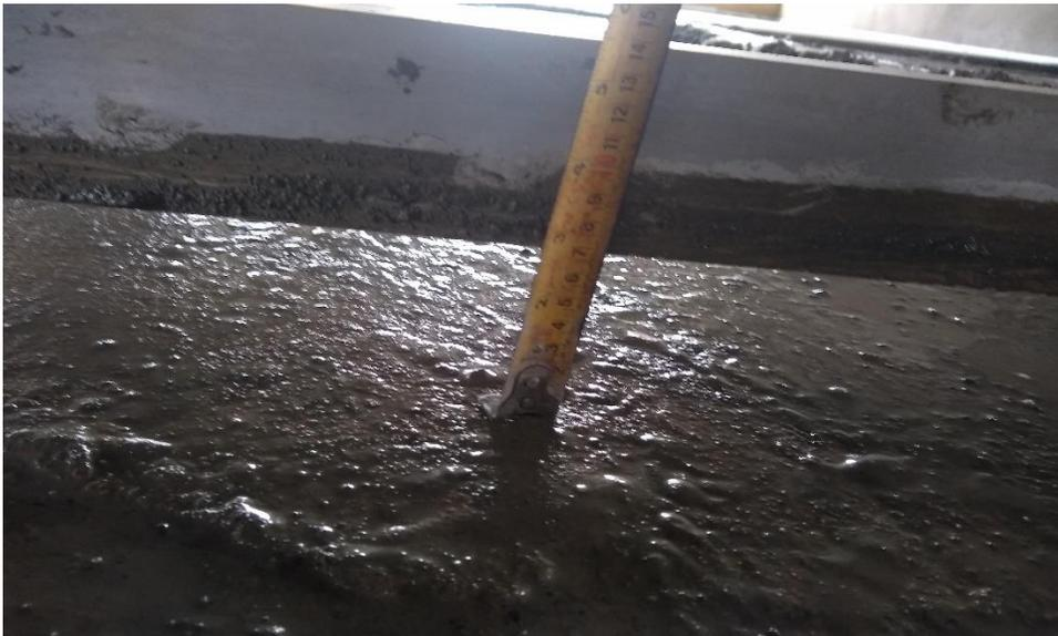
Nota. Verificación de espesor de morteros en piso 1 torre 2. Fuente: elaboración propia.
