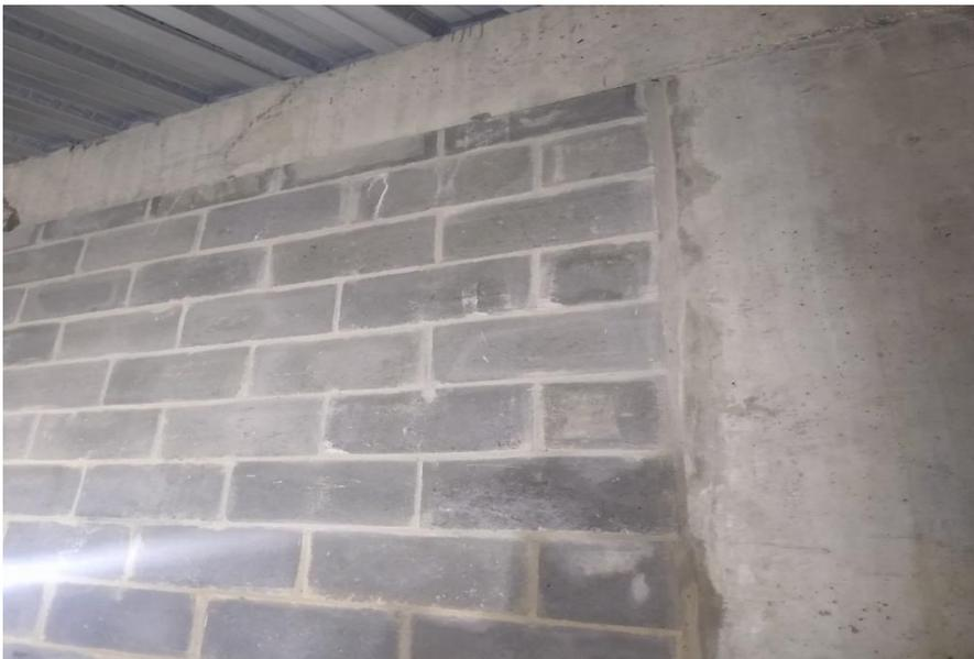
Nota. Verificación de fundida de dovelas en muro de bloque estructural. Fuente: elaboración propia
