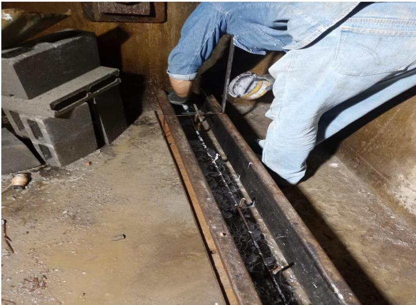
Nota. Supervisión de anclajes y adhesivos para fundida de bordillos. Fuente: elaboración propia
