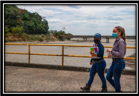
Imagen 13: inspección ocular concepción baja Rio Guayuriba
