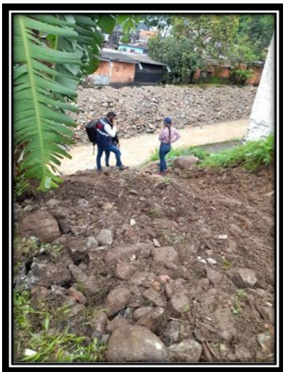
Imagen 23: supervisión de obra con el Contratista (servimacons)
