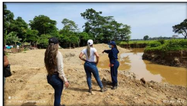
Imagen 21: supervisión de obra
