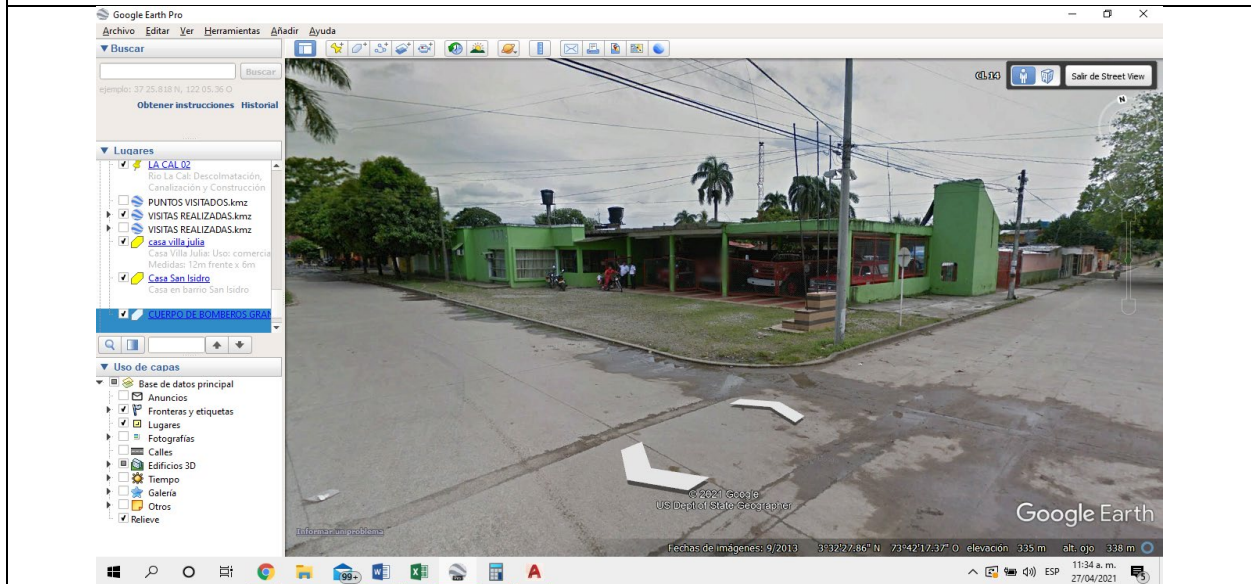
Foto 10: Análisis de edificación Voluntaria de Bomberos existente para el inicio de la planificación de actividades a ejecutar y sus respectivos costos y presupuesto. Fuente: Propia.
