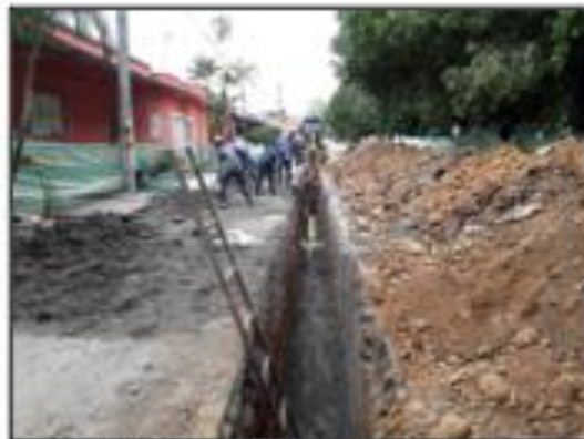
Imagen 1. Instalación de tubería cal# 13
