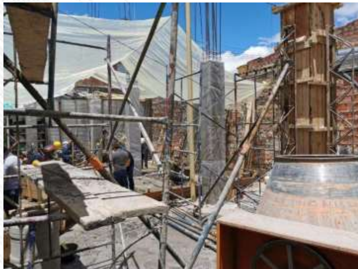
Figura 1 Supervisión de desencofrado de columnas,
