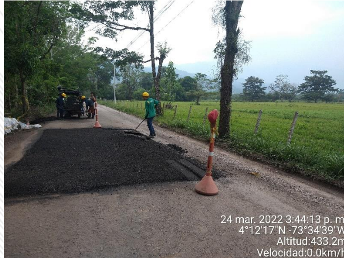
Compactación del material asfáltico
