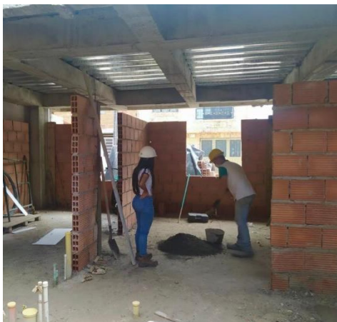
Ilustración 7 Fuente propia- Mampostería
