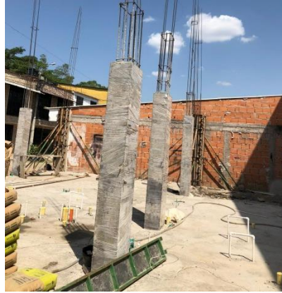
Ilustración 4 Fuente propia- Columnas 1 nivel
