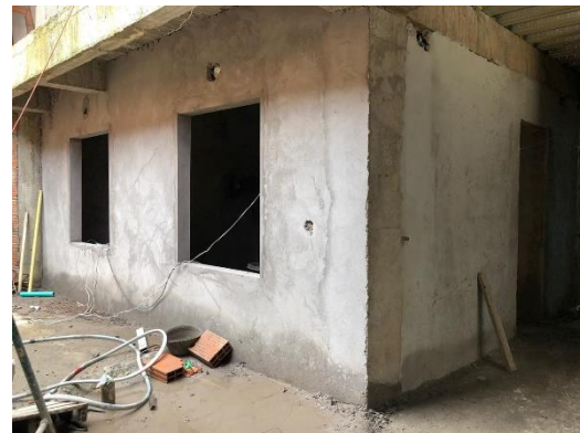
Ilustración 5 Fuente propia- pañete primer nivel
