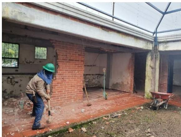
Ilustración 14. Demolición manual muro ladrillo tolete macizo/común, incluye trasiego y cargue manual
