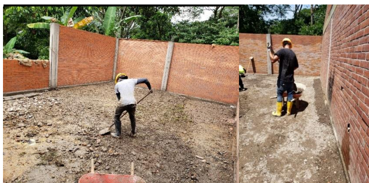
Ilustración 18. Relleno en material seleccionado proveniente de la excavación, compactación manual
