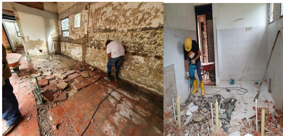
Ilustración 13. Demolición manual mortero piso 0.05 m, incluye trasiego y cargue manual
