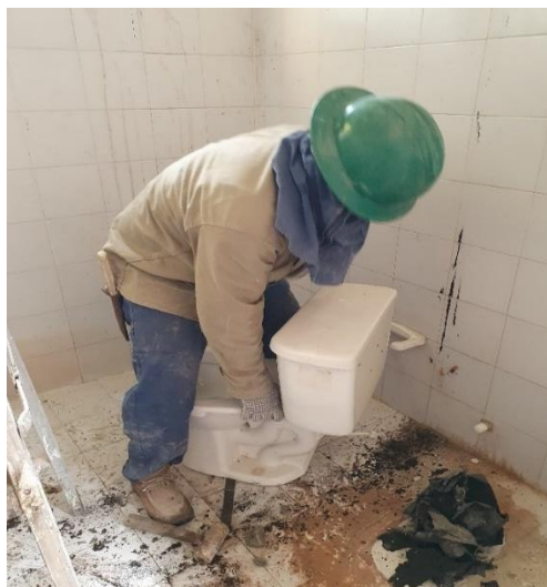
Ilustración 5. Desmante de sanitario, incluye traslado hasta sitio de cargue o almacenamiento
