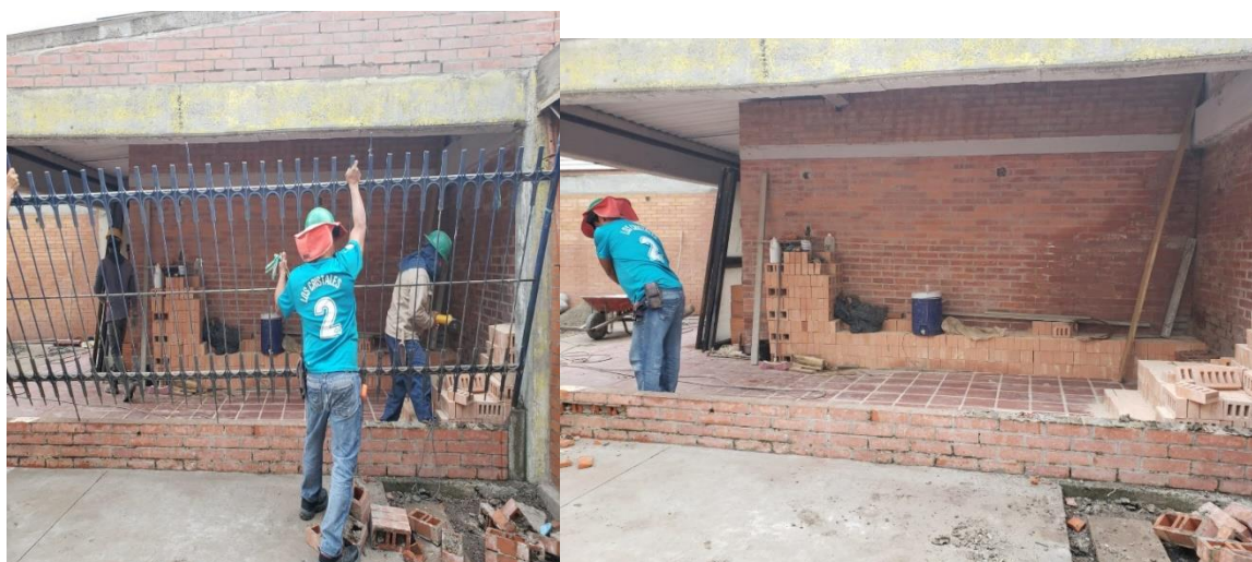
Ilustración 8. Desmante de rejas y ventanas metálicas, incluye traslado hasta sitio de cargue o almacenamiento
