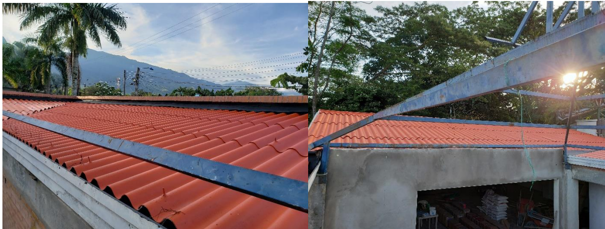
Ilustración 31. Pintura vinilo tipo coraza cara superior teja ondulada instalada
