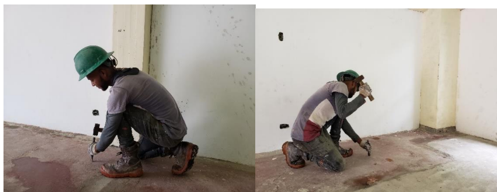
Ilustración 16. Picada de piso. incluye trasiego y cargue manual.
