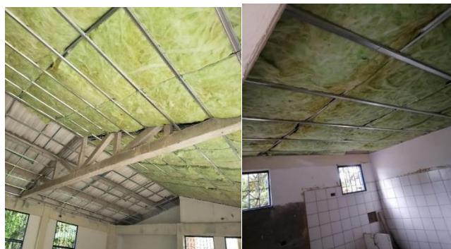
Ilustración 43. Suministro e instalación aislante térmico frescasa foil 3-1/2" ac 0.95
