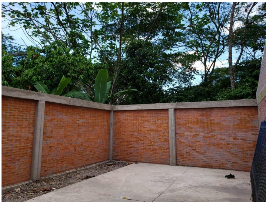
Ilustración 23. Viga aérea en concreto 20.7 MPA (3000 PSI) mezcla en obra, suministro y construcción
