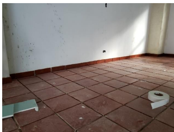
Ilustración 40. Guarda escoba en tableta de Gress (alta calidad)
