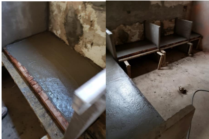
Ilustración 24. Mesón en concreto 20.7 mpa (3000 psi) mezcla en obra. suministro y construcción
