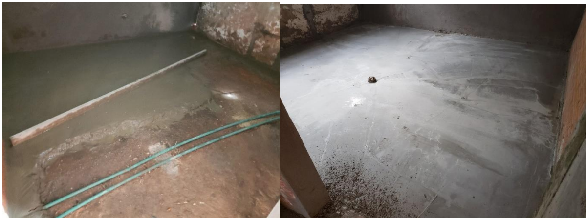
Ilustración 39. Afinado pisos mortero 1:4, e= 50 mm
