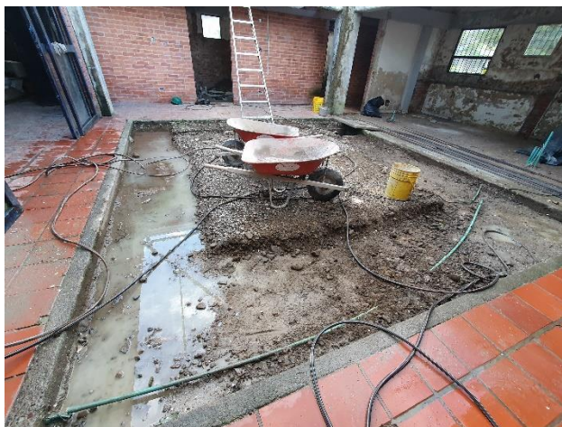
Ilustración 17. Excavación manual en material común H= 0 – 2.00 m incluye cargue
