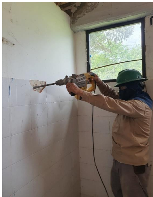
Ilustración 15. Demolición manual enchape cerámico, muros, incluye trasiego y cargue manual
