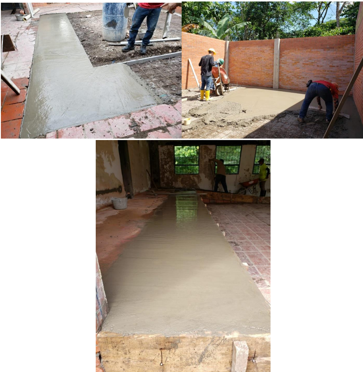
Ilustración 21. Placa de contrapiso en concreto impermeabilizado 20.7 MPA (3000PSI) mezcla en obra, suministro e instalación
