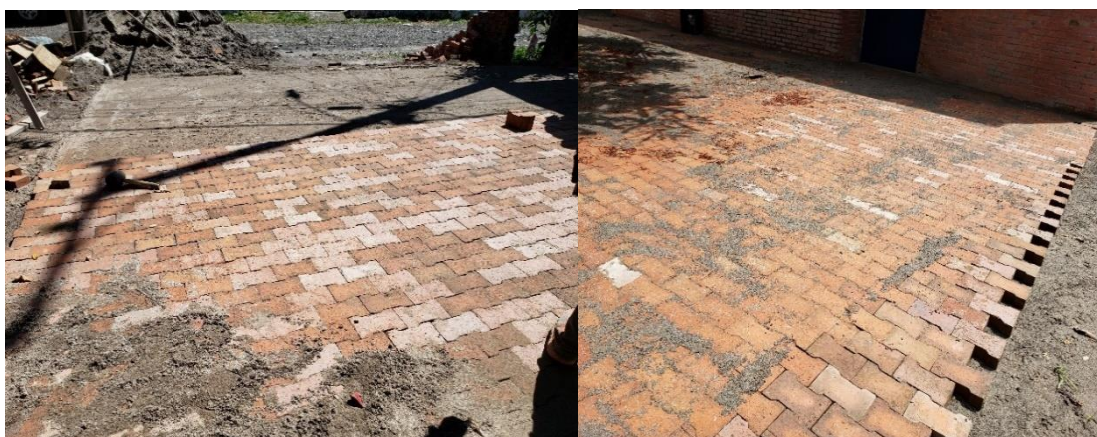
Ilustración 38. Piso en adoquín cuarterón de gres
