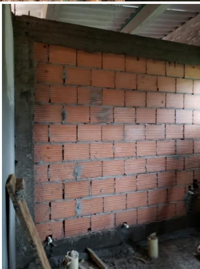
Ilustración 22. Columna en concreto 20.7 MPA (3000 PSI) mezcla en obra, suministro y construcción
