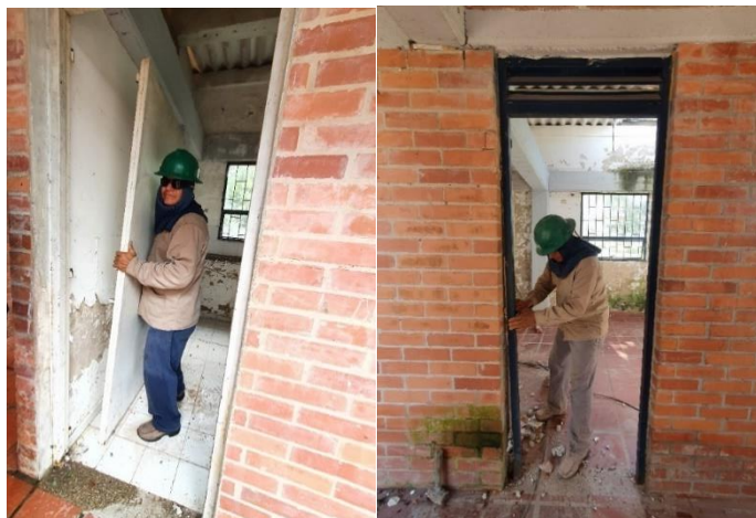
Ilustración 7. Desmante de marco y puerta, incluye traslado hasta sitio de cargue o almacenamiento
