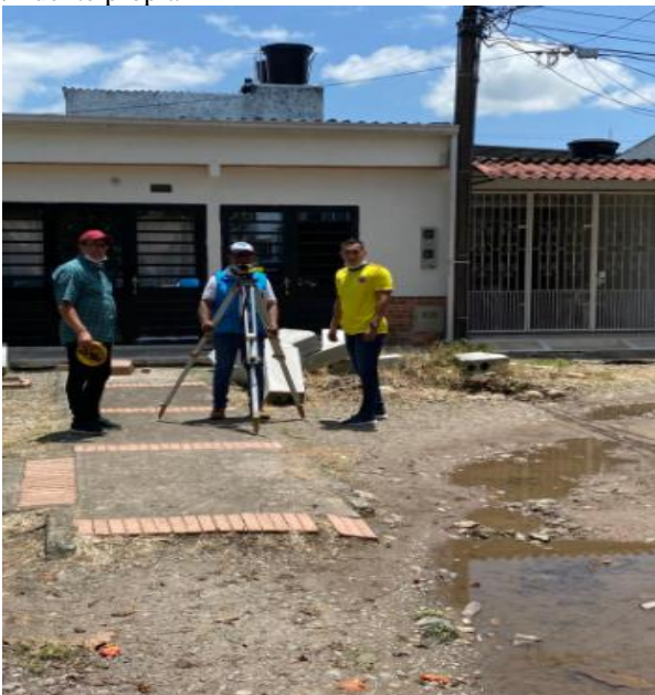
Ilustración 12 Nivelación vía La Rosita 2
