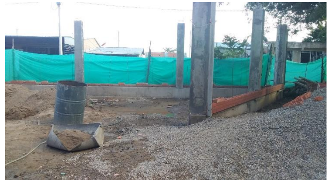
Ilustración 5 Fuente propia. Proyecto llano lindo relleno y compactación
