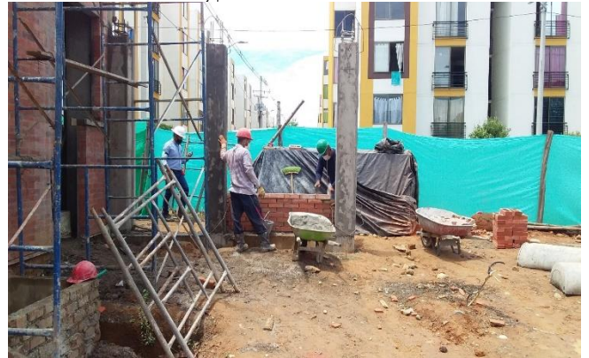
Ilustración 4 Fuente propia Proyecto llano lindo, mampostería
