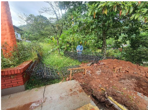
Figura 9. Acopio de acero
