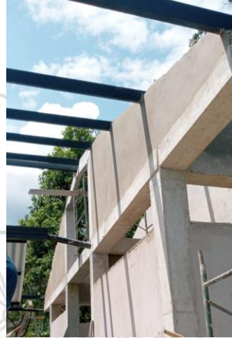
Figura 19. Instalación de correas
