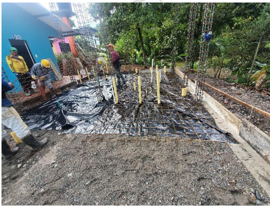
Figura 15. Instalación de acero
