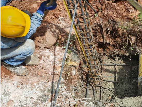
Figura 11. Nivelación de columnas
