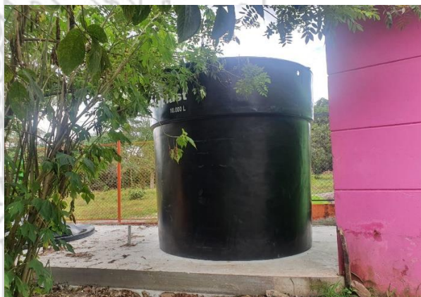
Figura 24. Instalación del tanque
