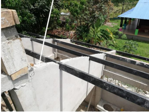
Figura 22. Instalación de correas
