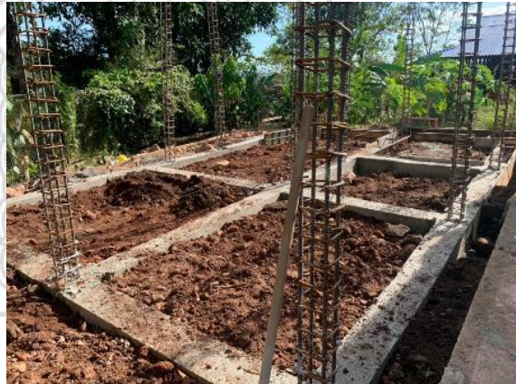
Figura 12. Vigas fundidas
