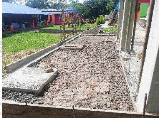
Figura 16. Nivelación de terreno
