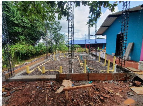
Figura 14. Tubería sanitaria
