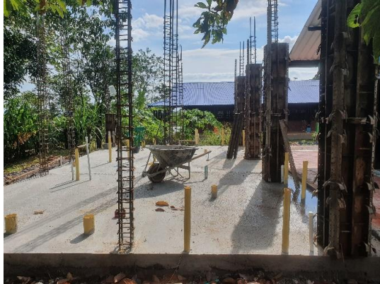
Figura 17. Encofrado de columnas
