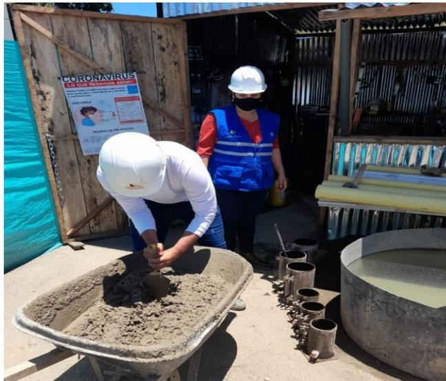
*Ilustración 11 Supervisión de tomas de muestra del concreto*
