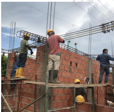
Imagen 22. Amarre de hierro vigas aéreas
