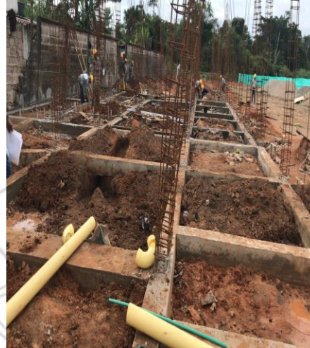
Imagen 15. Excavación tubería hidráulica
