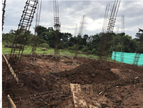
Imagen 6. Ubicación de zapatas y columnas
