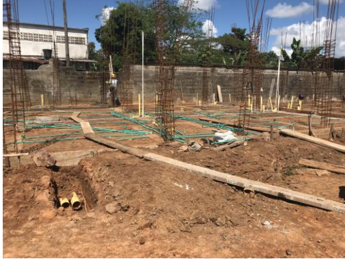
Imagen 18. Colocación de tuberías
