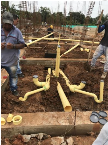
Imagen 16. Colocación de tubería
