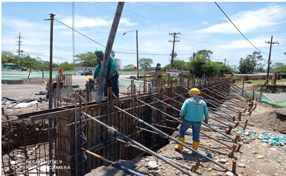
Imagen 8: Vaciado concreto vástago tipo b Fuente: Propia
