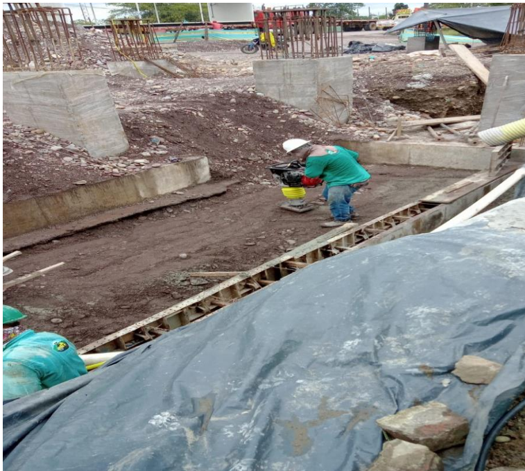
Imagen 4: Afirmado para zarpa muro tipo b Fuente: Propia
