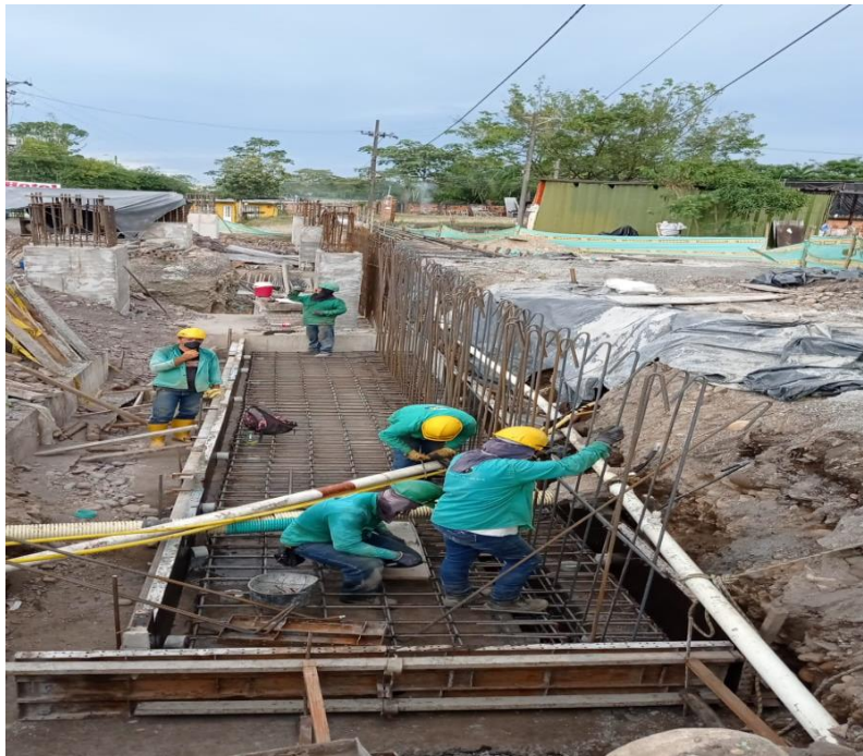
Imagen 5: Amarre acero de refuerzo para zarpa muro tipo b Fuente: Propia
