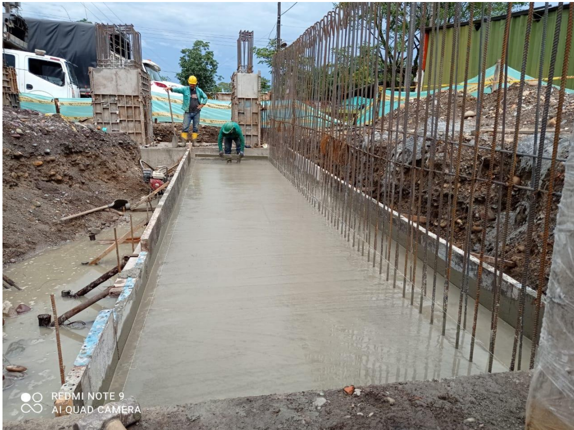
Imagen 6: Vaciado concreto zarpa muro tipo b Fuente: Propia
