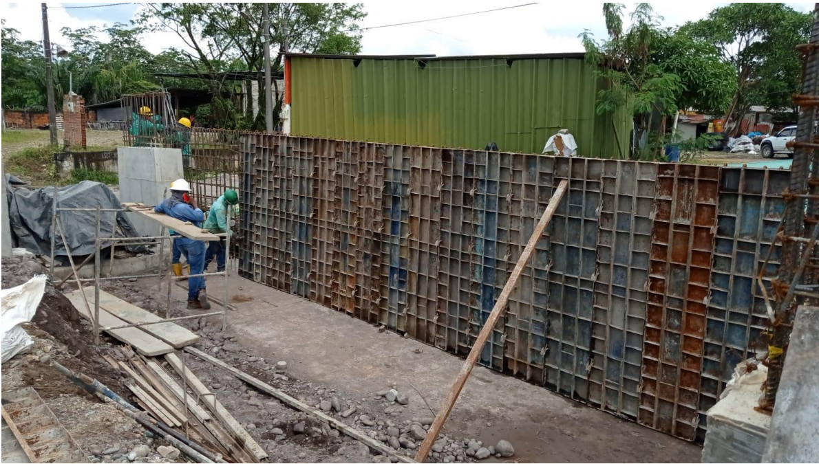
Imagen 7: Encofrada para vástago tipo b Fuente: Propia
