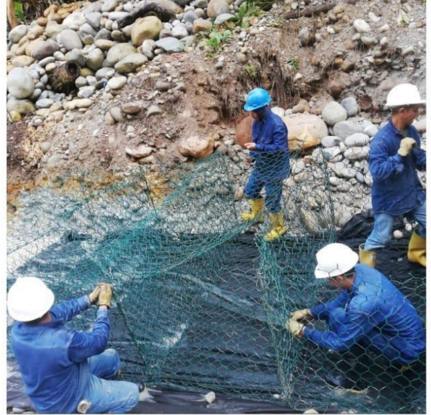
Ilustración 6. Construcción gaviones
