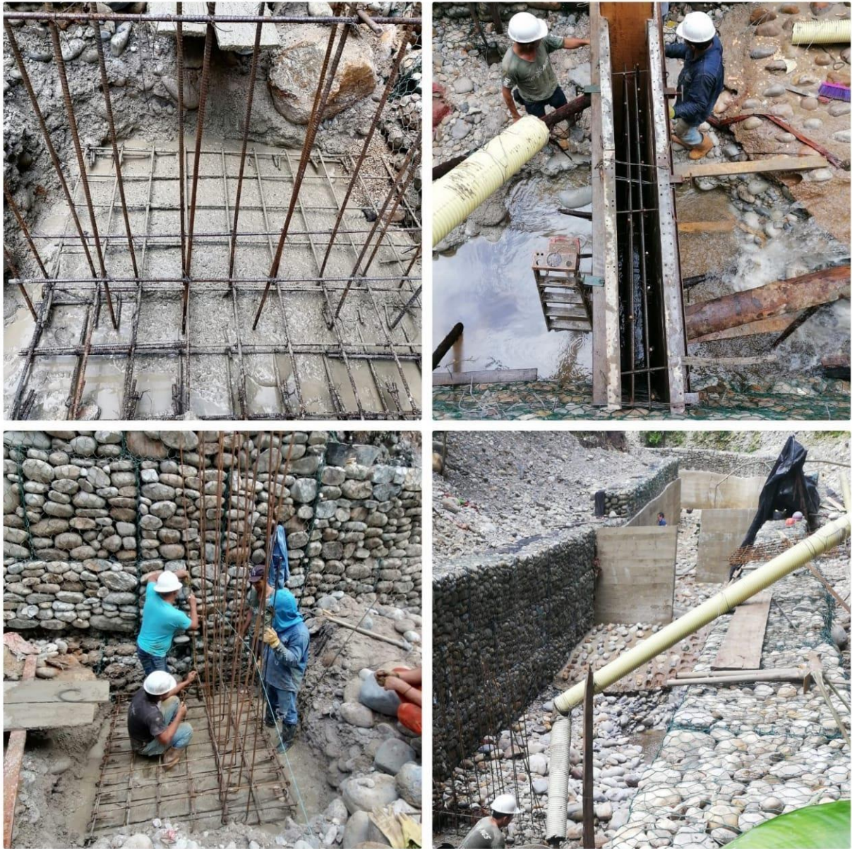
Ilustración 9. Muros disipadores de energía
