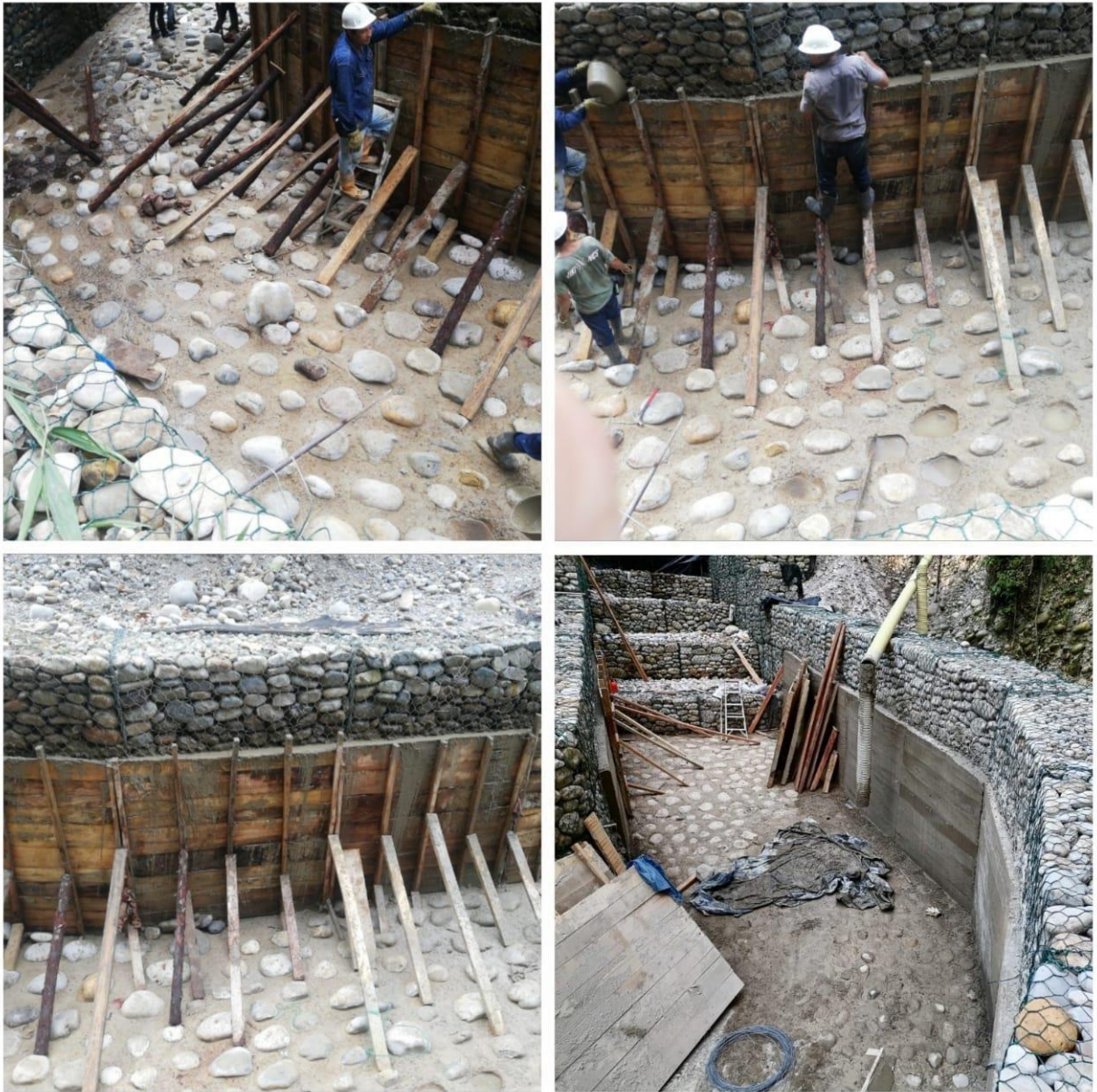
Ilustración 8. Recubrimiento de gavión
