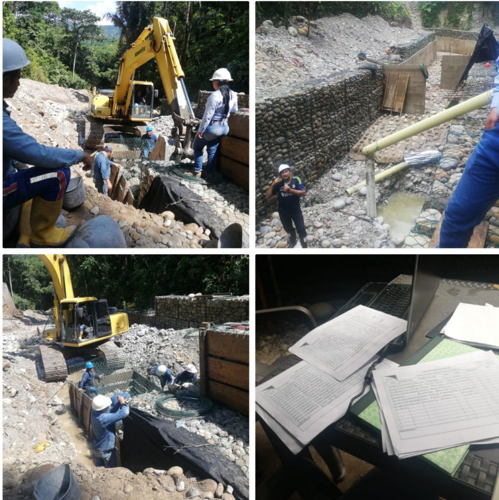
Ilustración 10. Supervisión en obra
