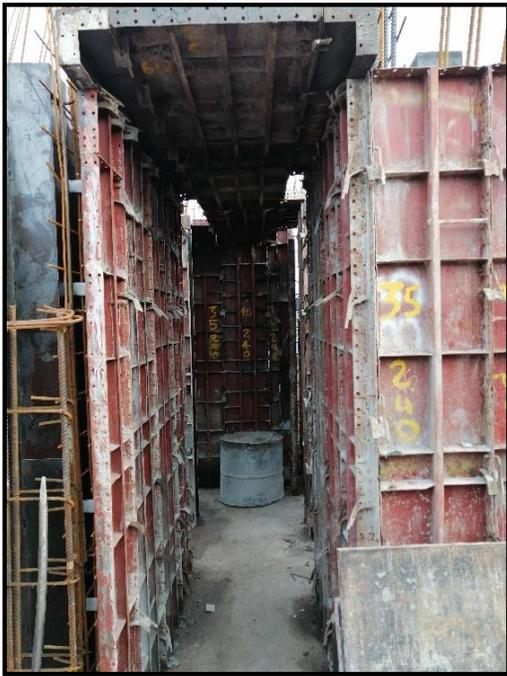
Figura 2. Encofrado de formaleta “chapeta-pin”. Fuente propia
