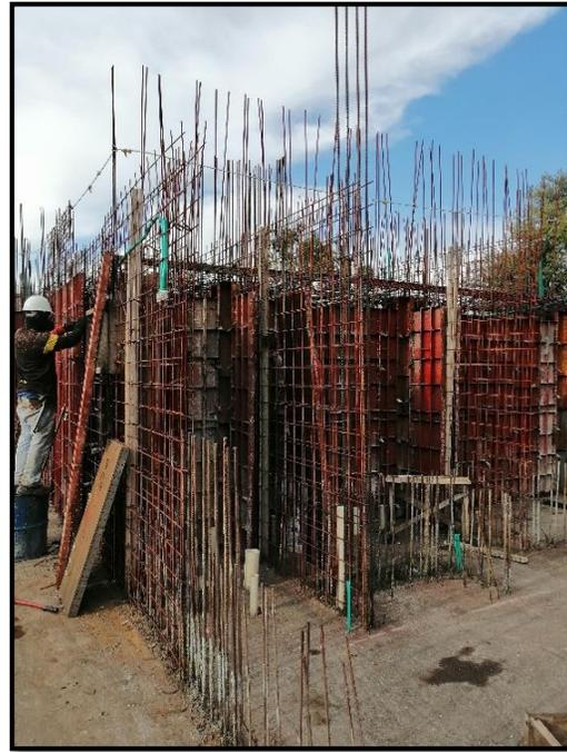
Figura 3. Encofrado de formaleta “chapeta-pin”. Fuente propia.
