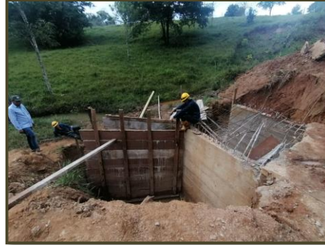
Ilustración 53. Armada formaleta Box Culvert
