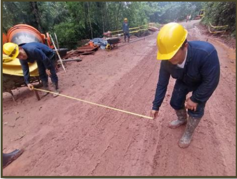
Ilustración 34. Medición ancha de calzada
