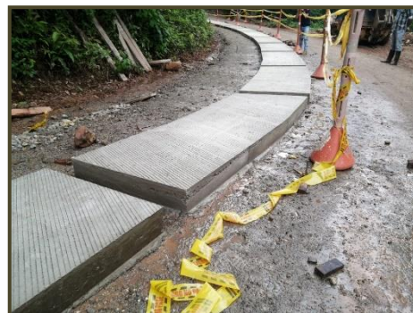
Ilustración 45. Tramo placa huella
