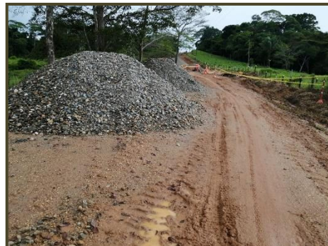
Ilustración 51. Acopio material Sub base
