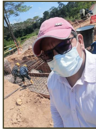
Ilustración 49. Construcción Box Culvert
