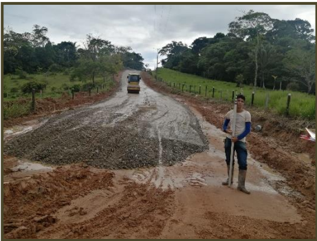
Ilustración 54. Trazado de niveles
