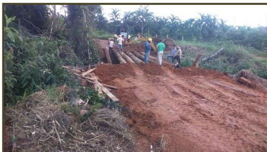
Ilustración 62. Adecuación puente en madera
