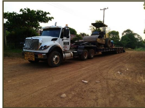
Ilustración 59. Traslado Vibro compactador
