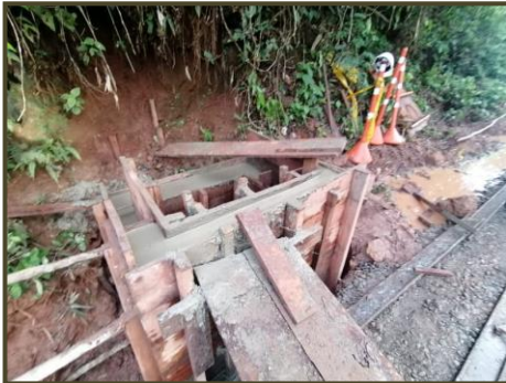
Ilustración 40. Fundición estructura captación Box Culvert
