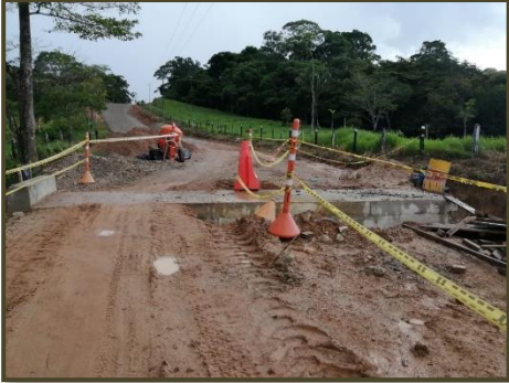
Ilustración 52. Construcción Box Culvert
