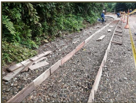
Ilustración 42. Armada formaleta
