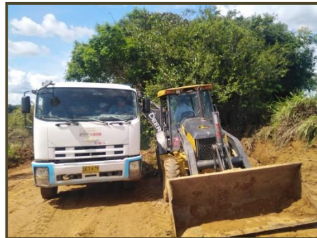
Ilustración 61. Cargue de material
