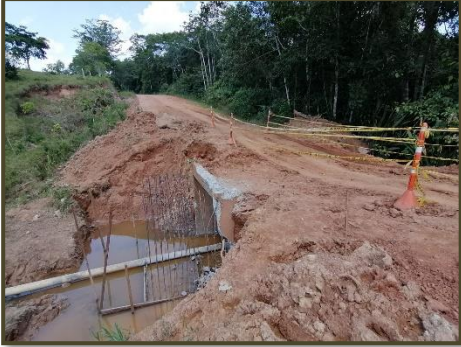
Ilustración 46. Ampliación Box Culvert
