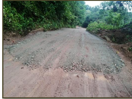
Ilustración 35. Extendido de Sub base
