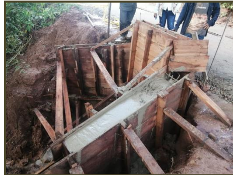
Ilustración 41. Fundición Aletas, guarda rueda de Box Culvert existente en obra.
