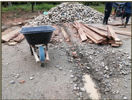
Ilustración 56. Excavación vigas riostra
