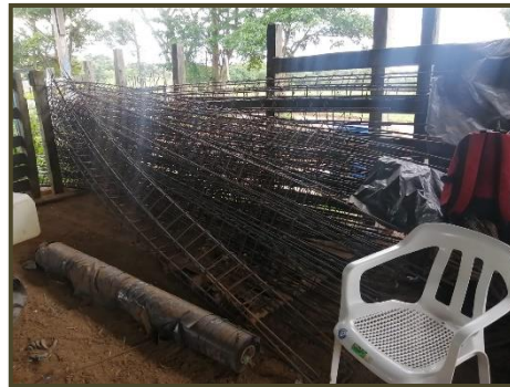
Ilustración 55. Acero de refuerzo vigas riostra
