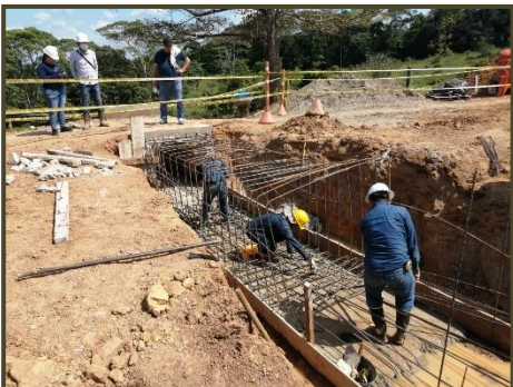
Ilustración 50. Hierro refuerzo Box Culvert
