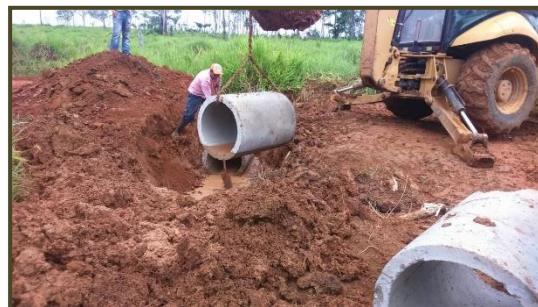
Ilustración 63. Instalación tubería de concreto
