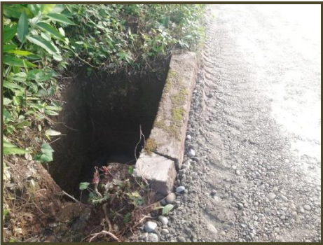
Ilustración 38. Inspección Box Culvert
