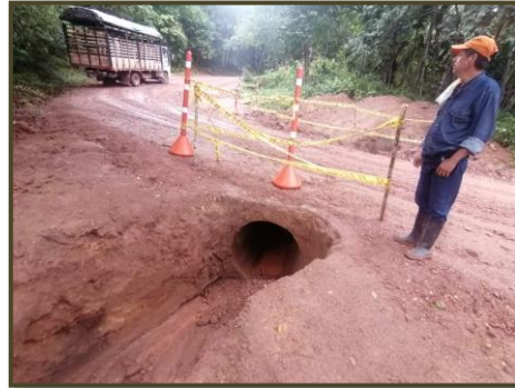
Ilustración 37. Mantenimiento Box Culvert
