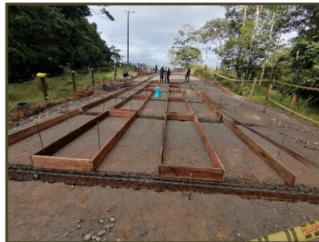
Ilustración 57. Armada de formaleta placas
