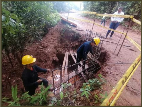
Ilustración 36. Ampliación Box Culvert
