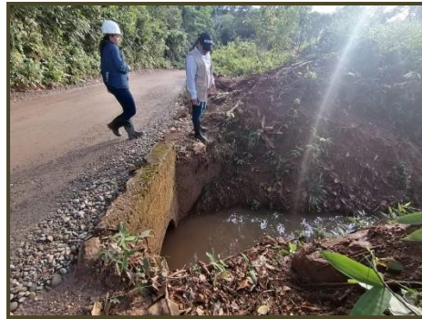
Ilustración 39. Inspección Box Culvert
