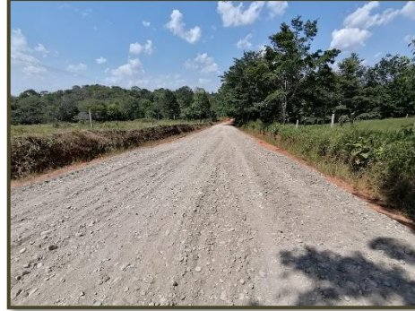
Ilustración 47. Extendido de Sub base
