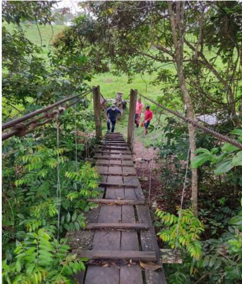
Ilustración 4. Visita técnica puente colgante
