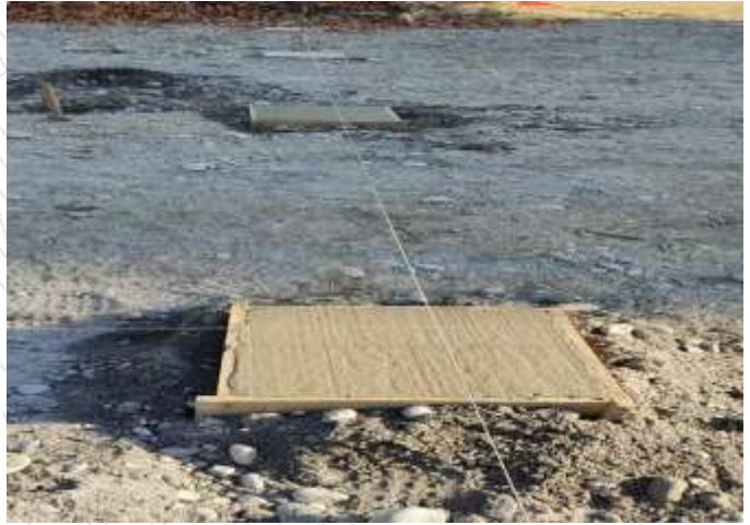
Ilustración 16 Construcción de cimentación.
