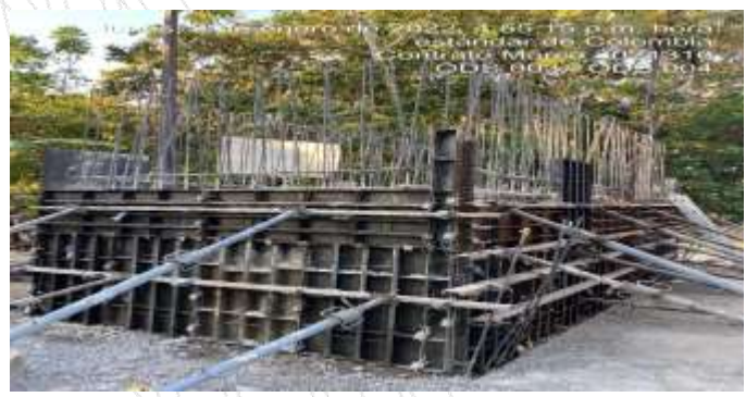
Ilustración 20 Construcción de los tanques de concreto.
