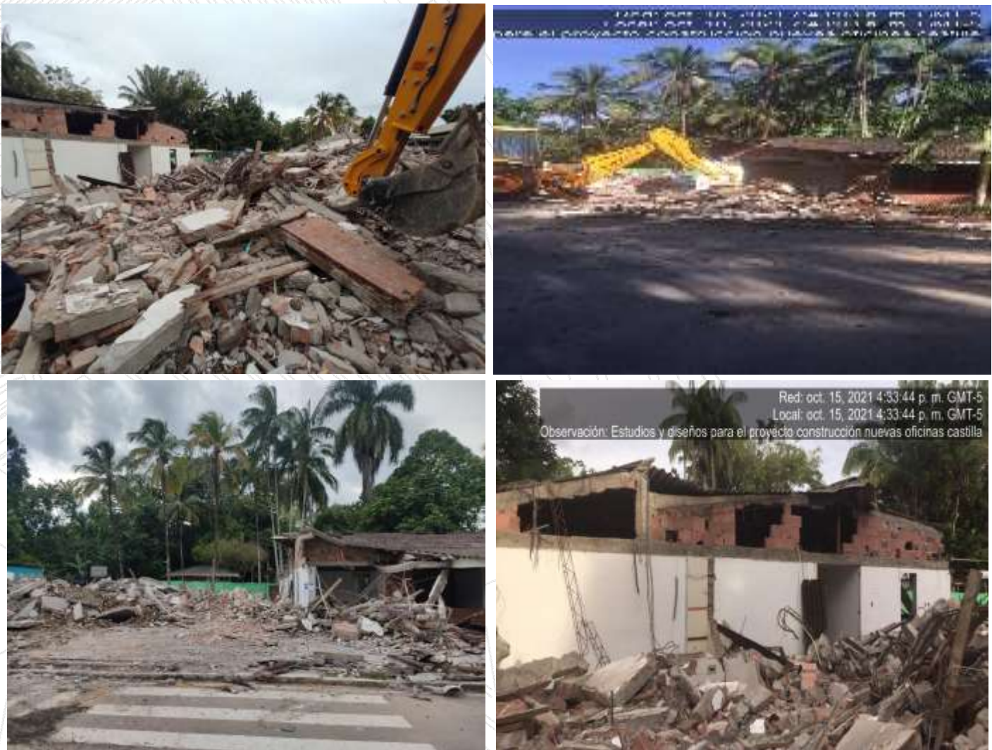
Ilustración 14 Demolición de las oficinas antiguas.
