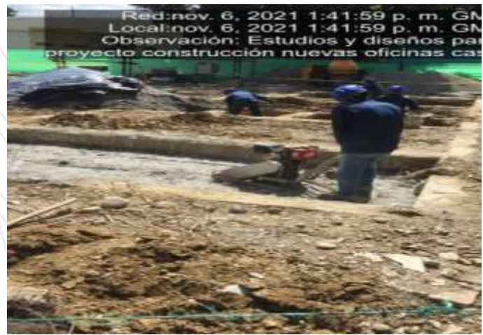
Ilustración 15 Mejoramiento y estabilización del suelo para cimentación de las nuevas oficinas.
