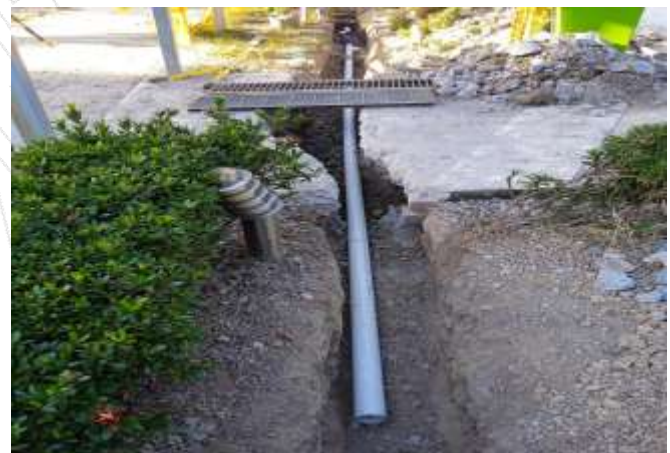
Ilustración 22 Construcción de la red hidráulica y sanitaria.
