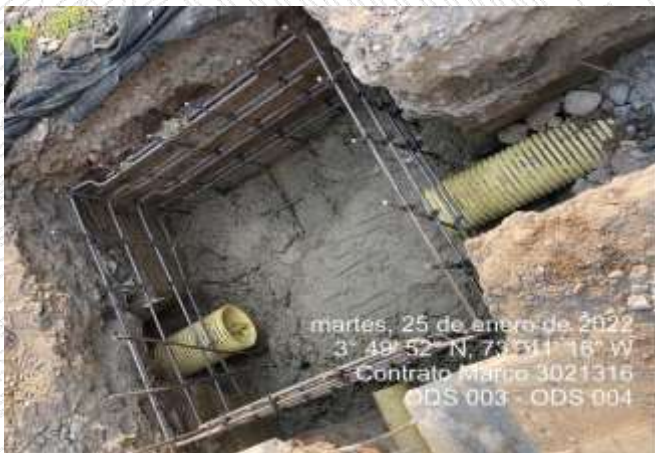
Ilustración 22 Construcción de la red hidráulica y sanitaria.
