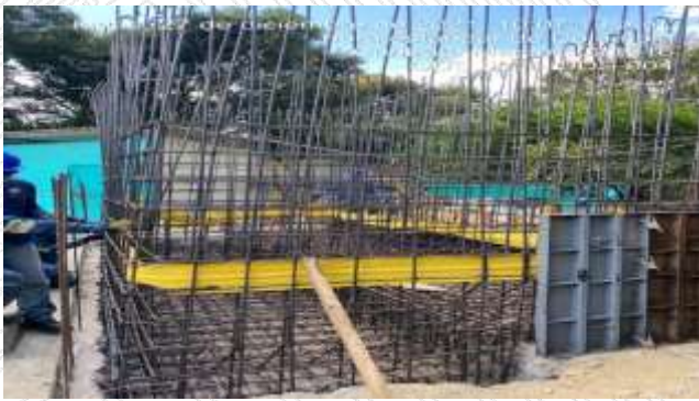
Ilustración 20 Construcción de los tanques de concreto.
