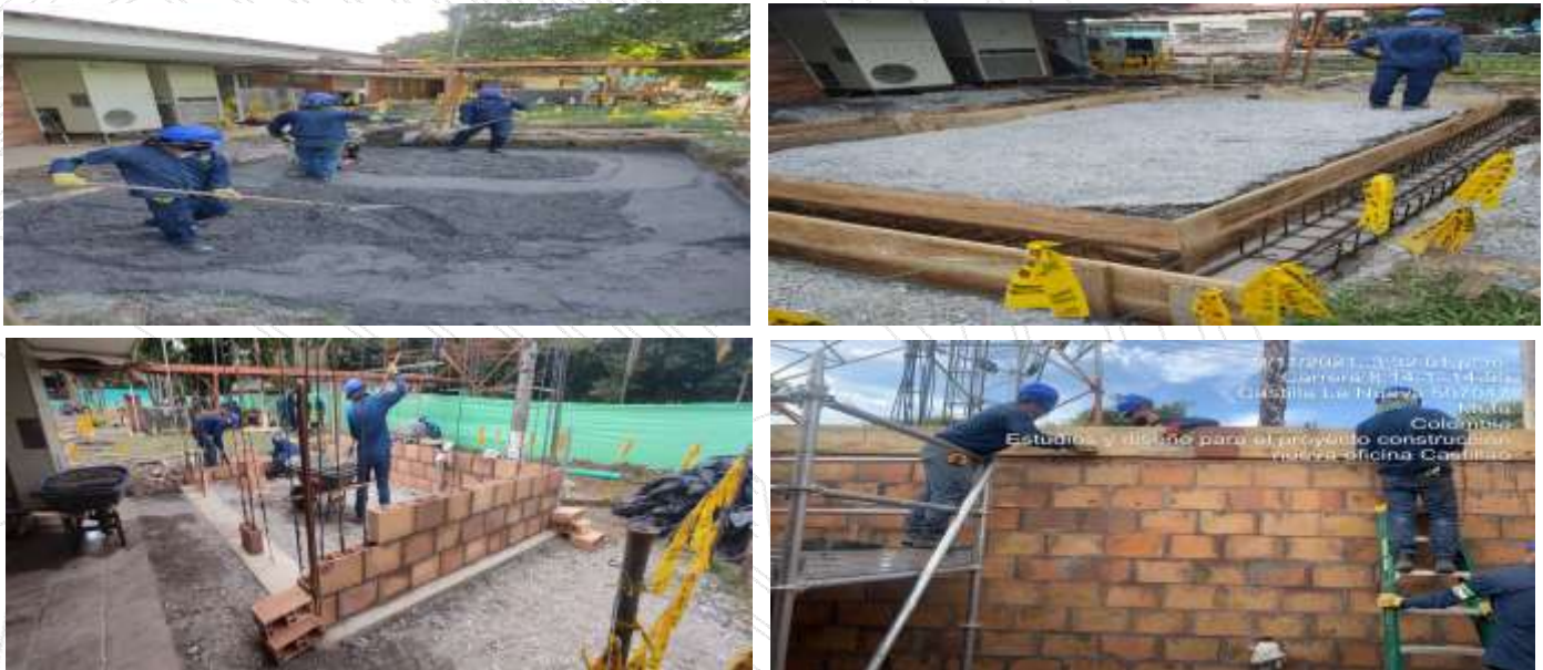
Ilustración 17 Construcción del cuarto de comunicaciones.
