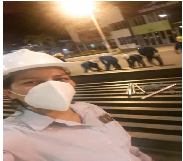
Ilustración 7. Recibir material estructura metálica: IPE 140, 180, 240. HEA.
