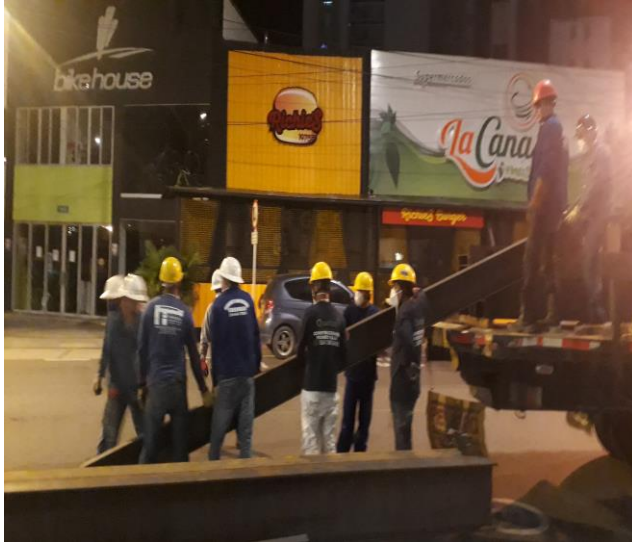
Ilustración 7. Recibir material estructura metálica: IPE 140, 180, 240. HEA.
